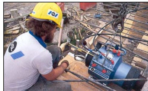
colocação em carga, medição de alongamentos, bloqueamento dos cordões
