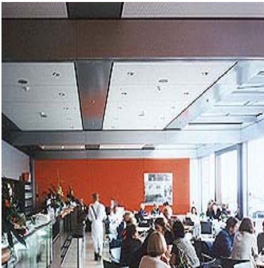
Figura 10 - Placas perfuradas Knauff entre as vigas de aço visíveis. Restaurantes no piso superior do Parlamento de Berlim (Reichstag).
