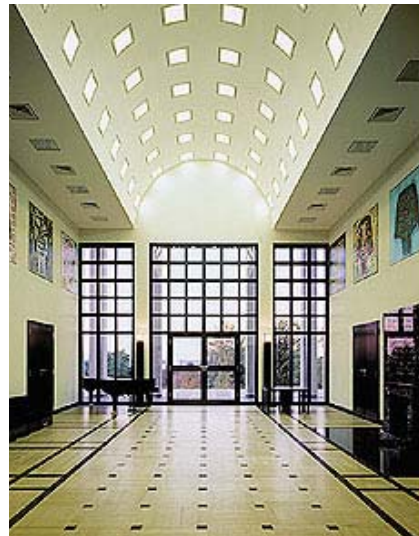
Figura 11 - Tecto em gesso. Entrada principal da Embaixada alemã em Washington (proj. Arq. O.M. Ungers) Pré-fabricação e montagem na Alemanha.
