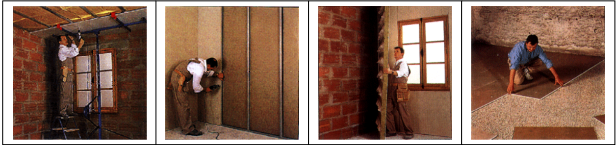
Figura 9 – Aplicação de gesso cartonado Placoplatre.
