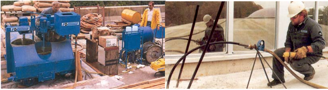
Figura 86 –Equipamento para fabrico (à esquerda) e injeção (à direita) de calda.
