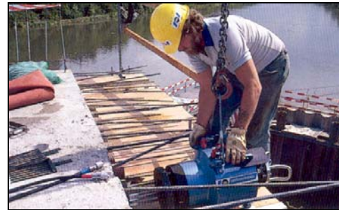
colocação do macaco
