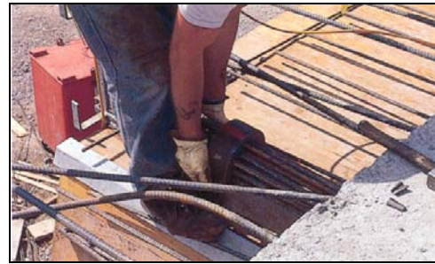
colocação da cabeça de ancoragem
