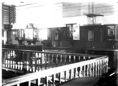
Fig. 14 — Galeria de Medidas Eléctricas
