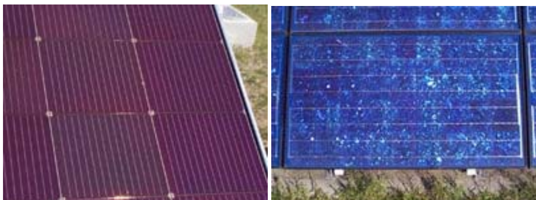
Fig. 4 – Painéis solar de células de a-Si (esquerda) e células poli-cristalinas (direita)
