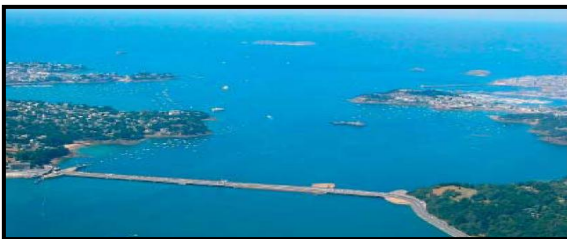
Figura 4 – Central de energia das marés de La Rance, França – imagem aérea
