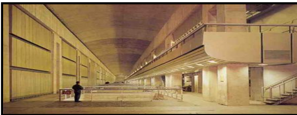
Figura 5 – Central de energia das marés de La Rance, França – imagem do interior
