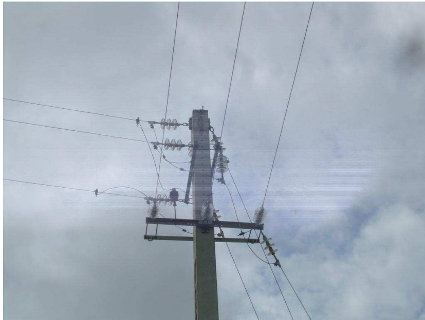
Figura 9 – Derivação e travessa colocada a 90 graus para continuação da linha
