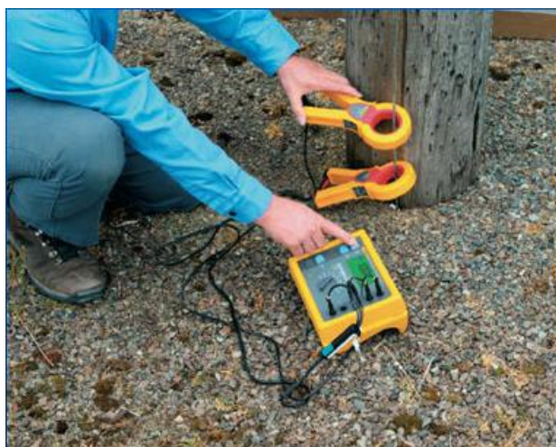
Figura A.2 - Método de medida da resistência de terra sem eléctrodos de terra auxiliares.
