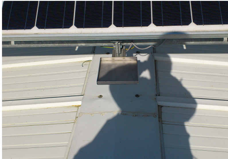
Figura 5.13: Suporte e posição dos sensores
