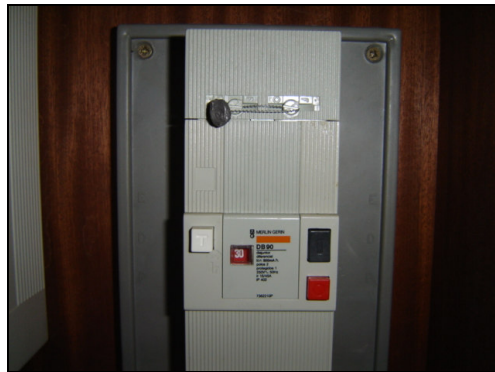
Fig. 11 - Disjuntor diferencial
