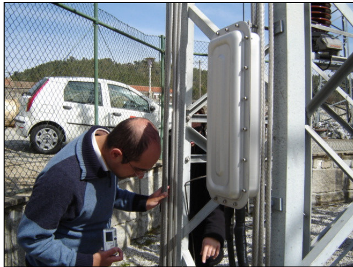
Fig. 24 - LABELC na Subestação de Vidago
