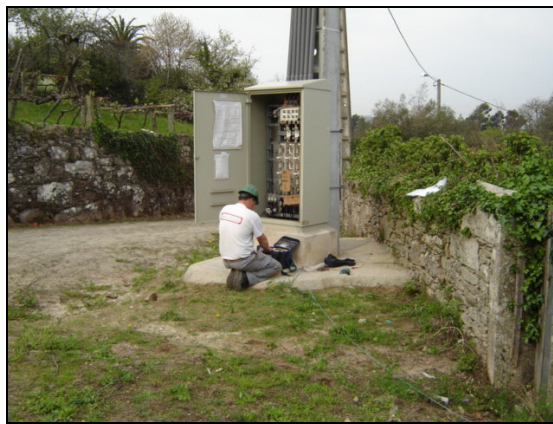
Fig. 47 - Riba de Âncora: Técnico montando o Array Wenner.
