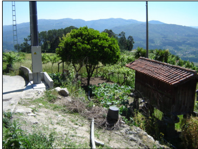
Fig. 51 - Local da montagem do PT
