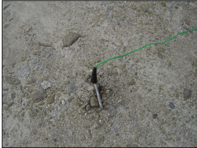
Fig. 49 - Riba de Ancora: Um dos eléctrodos enterrado no solo.
