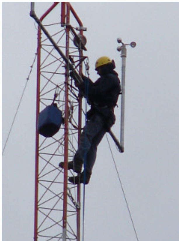
Figura 11 – Torre meteorológica com anemómetro suficientemente afastado de modo a não sofrer obstruções.
