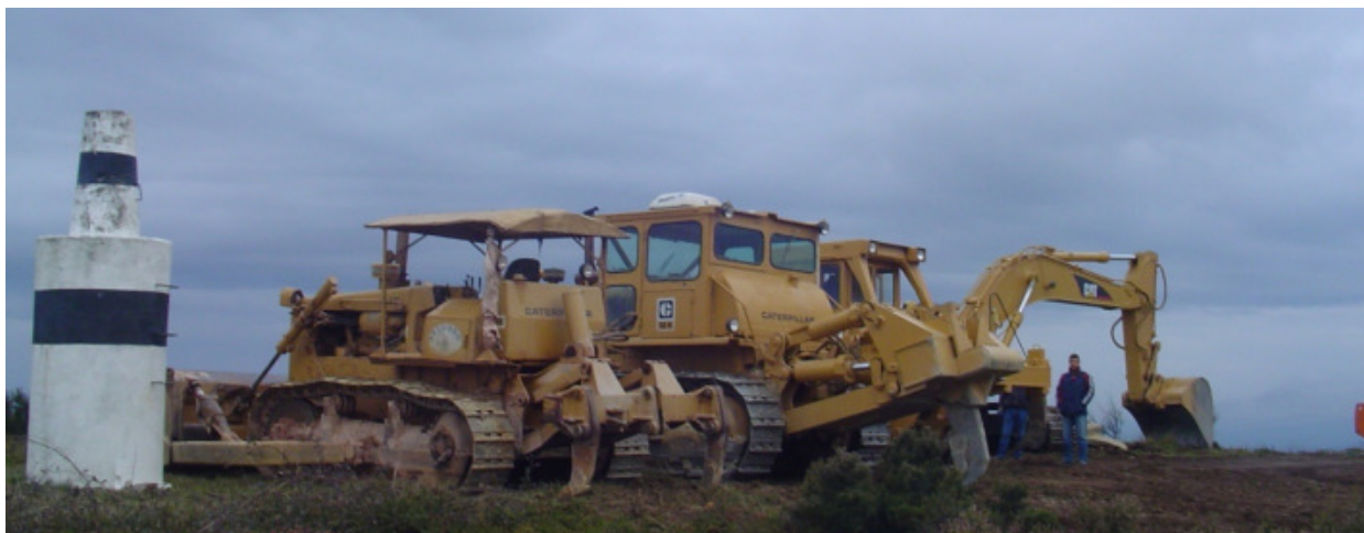
Figura 31 – Equipamento utilizado na abertura de acessos
