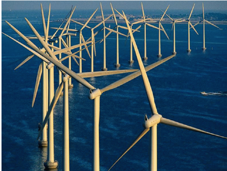
Figura 1- Parque eólico offshore 2
