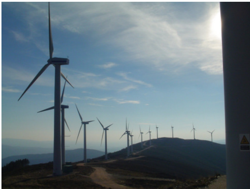
Figura 12 – Exemplo de um parque eólico com localização alinhada na perpendicular dos ventos dominantes
