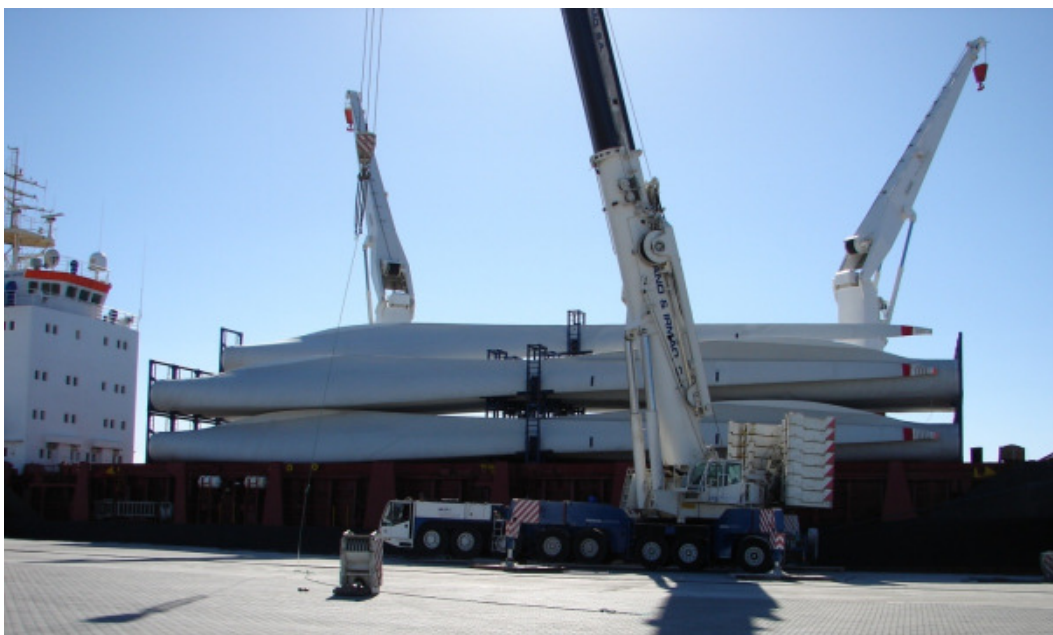
Figura 46 – Descarregamento de pás de aerogeradores no porto marítimo
