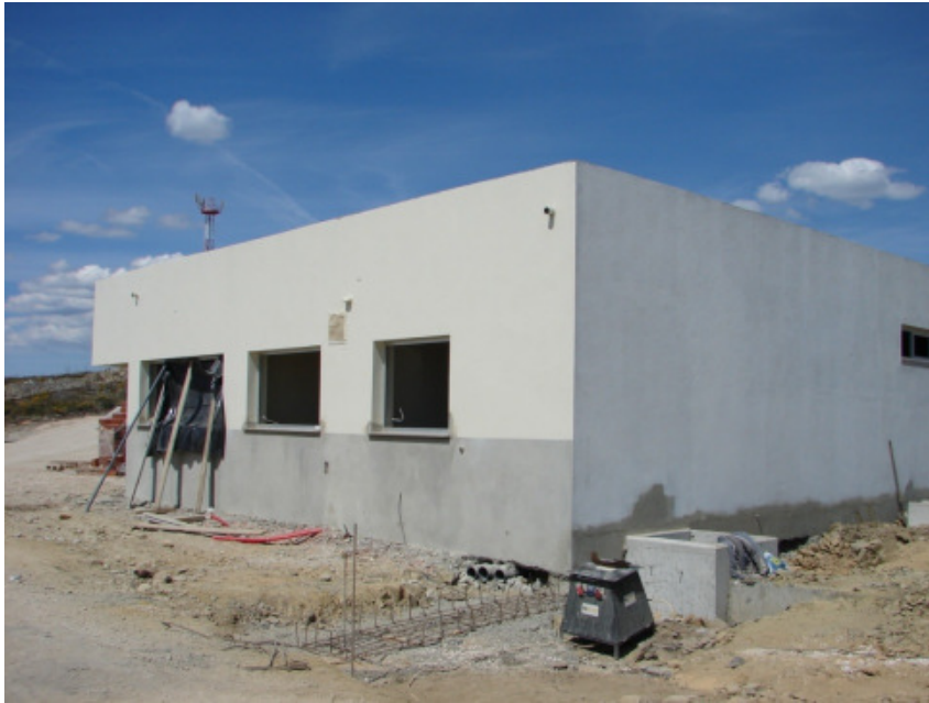
Figura 34 – Construção de um Edifício de Comando
