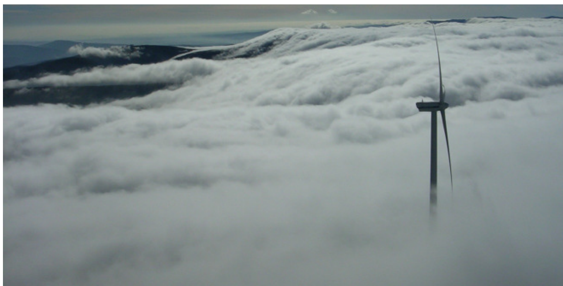
Figura 7 – Aerogerador com 80m e com 3Mw de potência.
