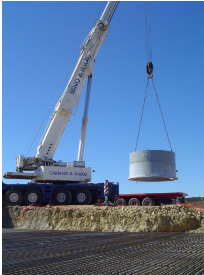
Figura 32 – Colocação de um anel de fundação na base
