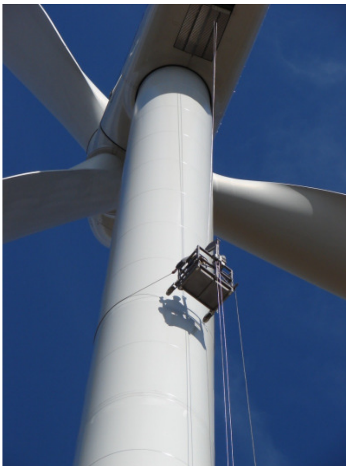
Figura 38 – Manutenção exterior num aerogerador
