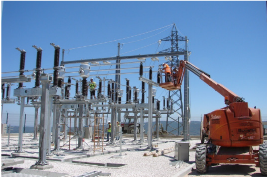
Figura 23 – Construção da Subestação
