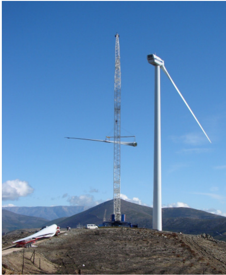
Figura 36 – Montagem das pás de um aerogerador
