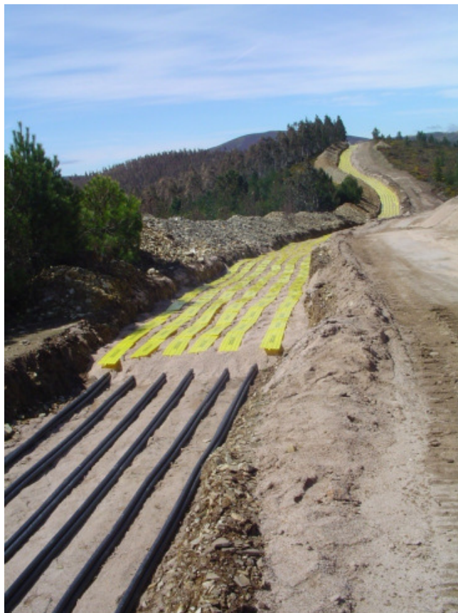
Figura 33 – Colocação de cabos de média tensão em vala.
