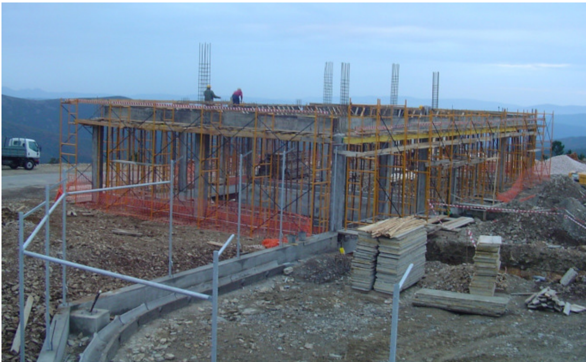
Figura 22 – Construção de um Edifício de Comando
