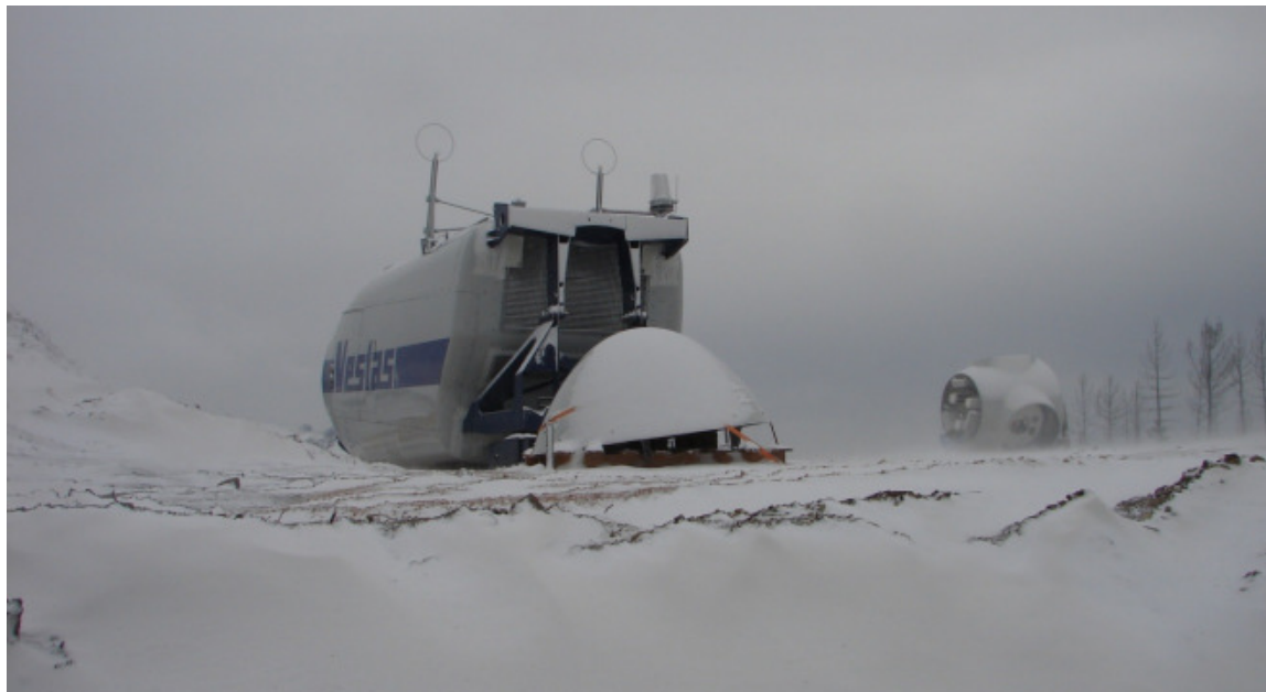
Figura 37 – Equipamento na plataforma. Pronto a ser montado
