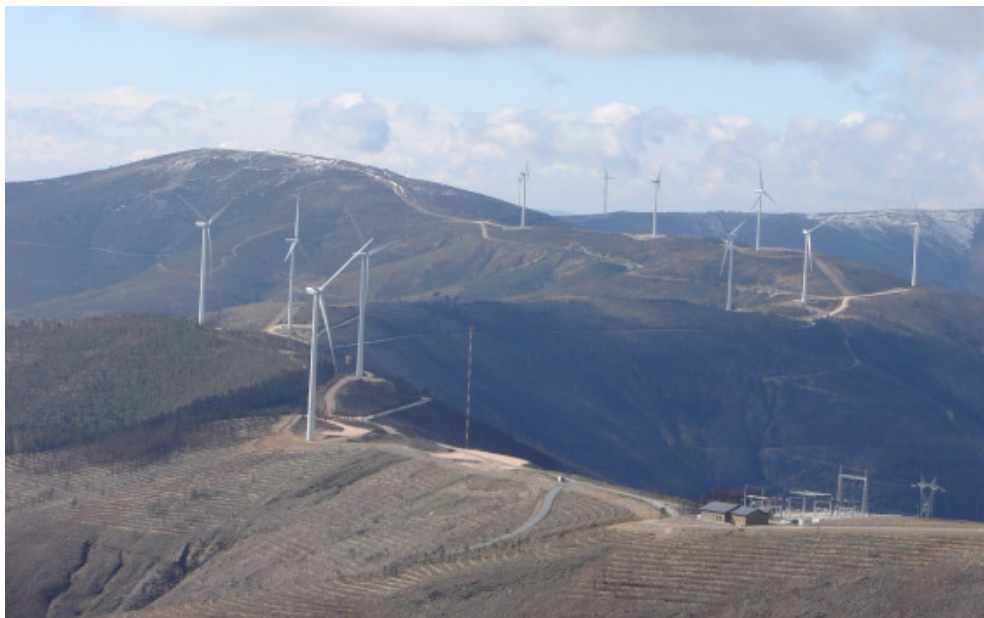
Figura 14 – Exemplo de Parque Eólico construído em local de difícil acesso
