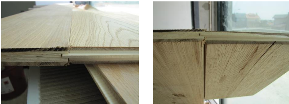
Fig. 5.31 – Pormenores do encaixe entre régua.
