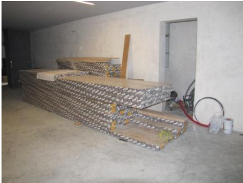
Fig. 5.18 – Armazenamento do soalho.
