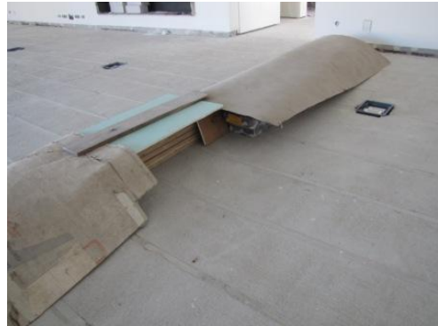
Fig. 5.18 – Armazenamento do soalho.
