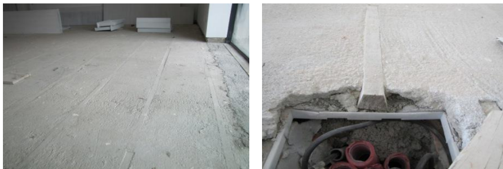
Fig. 5.17 – Suporte em betonilha e ripado de madeira.
