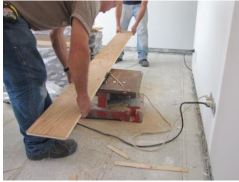
Fig. 5.27 – Corte longitudinal com serra eléctrica.
