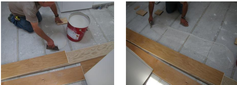
Fig. 5.22 – Espalhamento com espátula dentada.
