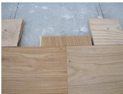
Fig. 5.26 – Cunha de estabilização.
