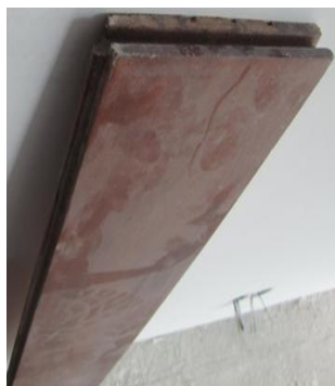
Fig. 3.6 – Régua de parquet maciço com encaixe à direita.
