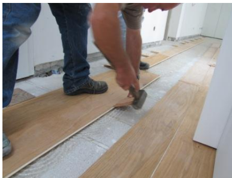
Fig. 5.25 – Encaixe da segunda fiada.
