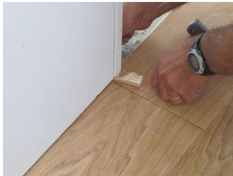
Fig. 5.28 – Cunha auxiliar de aperto.
