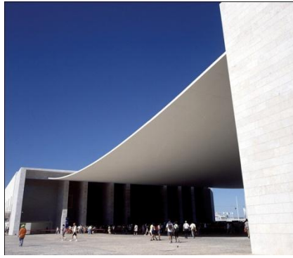
Fig. 2.2 – Estrutura em betão armado, Pavilhão de Portugal [10]
