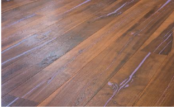
Fig. 4.11 – Madeira tratada com resina colorida de preenchimento. [25]
