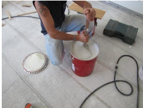
Fig. 5.21 – Homogeneização da cola.
