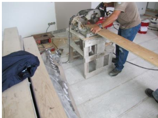
Fig. 5.20 – Corte transversal com serra eléctrica.
