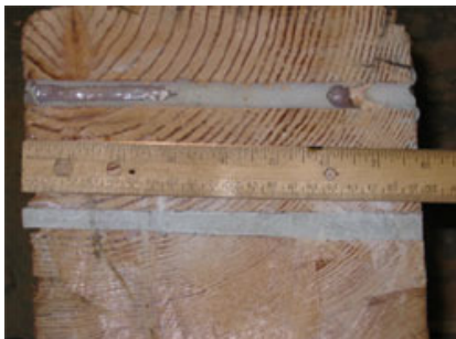
Fig. 5.9 – Viga reforçada com compósitos de FRP.
