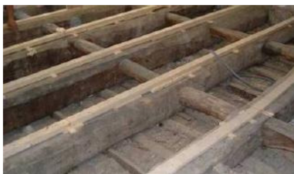
Fig. 5.46 – Chãos aplicados em pavimento antigo de madeira (Ilharco et al.;2007).
