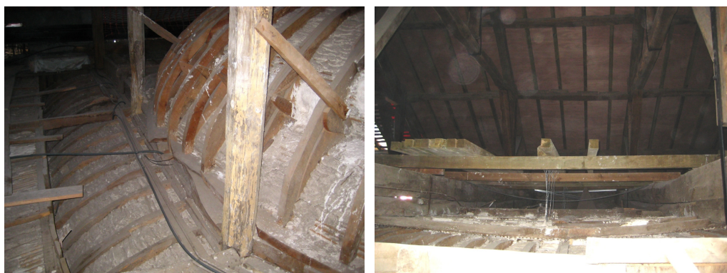
Fig. 6.11 – Reverso da abóbada e seu escoramento aos pilares (à esquerda) e sistema de suporte a elementos de madeira (à direita).
