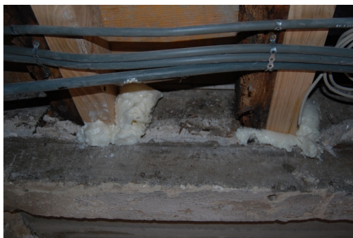
Fig. 6.27 – Reforço de apoios com recurso a argamassas de epóxico.
