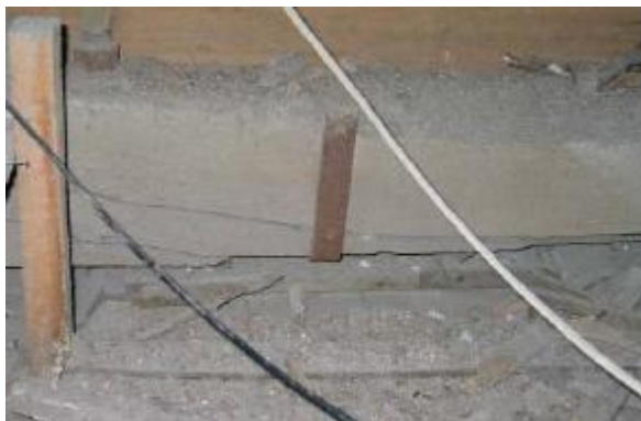
Fig. 5.33 – Uso de cinta metálica para reforço de pavimento no Convento de Corpus Christi, Vila Nova de Gaia, (Costa et al.; 2007).
