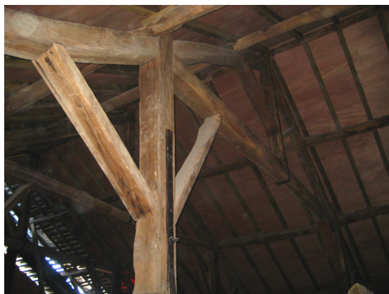
Fig. 6.10 – Estrutura principal em madeira da cobertura.
