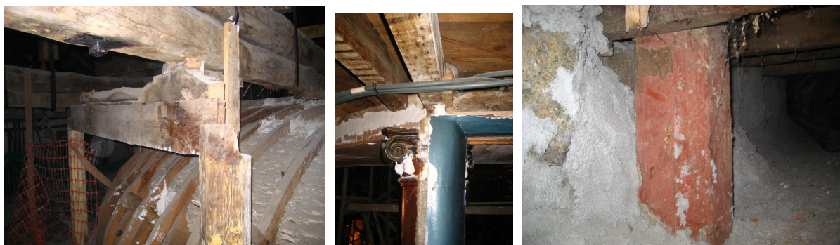
Fig. 6.14 – Topo dos pilares e sistema de travamento (à esquerda). Ao centro encontra-se pormenor de ornamentação do pilar e à direita a base do pilar.
