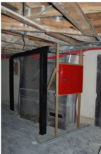
Fig. 6.21 – Colocação de escoramento para apoio dos elementos estruturais dos pavimentos devido a colocação de condutas do sistema AVAC.
