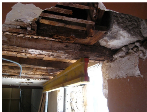
Fig. 6.23 – Correcção de apoio do pavimento junto a porta para o exterior.
