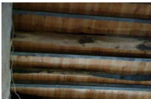
Fig. 5.47 – Utilização de perfis metálicos intercalados com as vigas de madeira existentes, Mosteiro de Tibães, Braga (Dias;2008).
