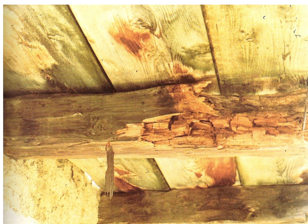
Fig. 4.7 – Exemplo de podridão cúbica – Serpula lacrymans G (Tampone;2002).
