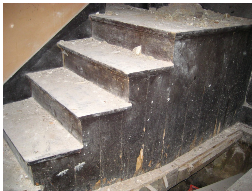
Fig. 6.13 – Escadas de acesso a frisa no rés-do-chão.
