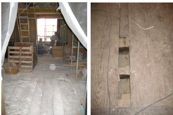
Fig. 6.20 – Pavimento do Salão Nobre.
