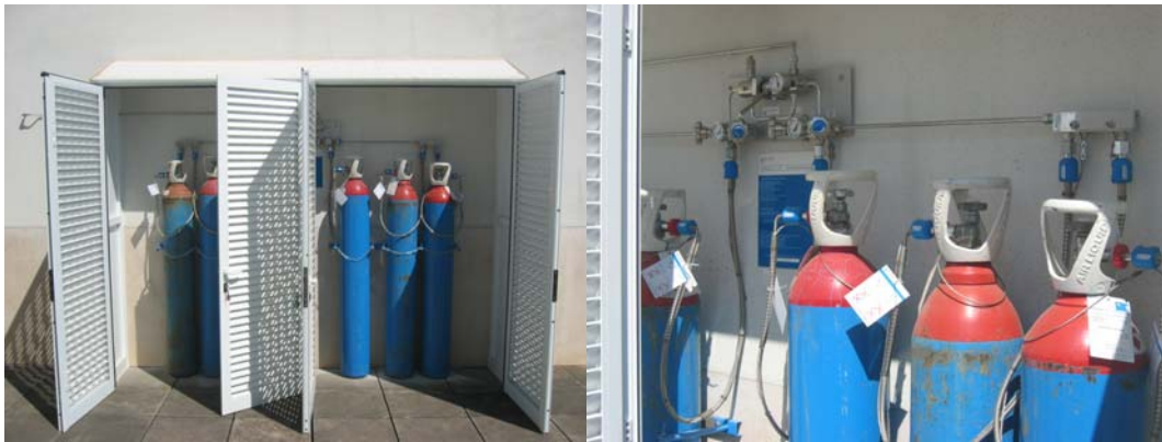
Figura 9 - Solução implementada para o armazenamento de hidrogénio.
