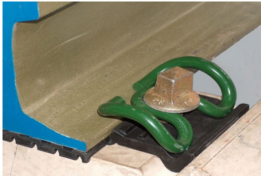
Figura 1: Esquema de la sujeción de vía
