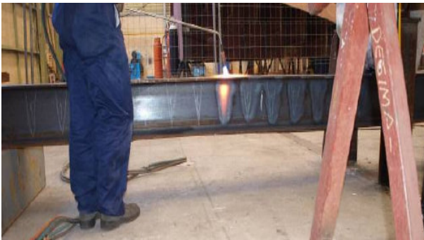
Figura 1. Enderezado por llama sobre perfil metálico
