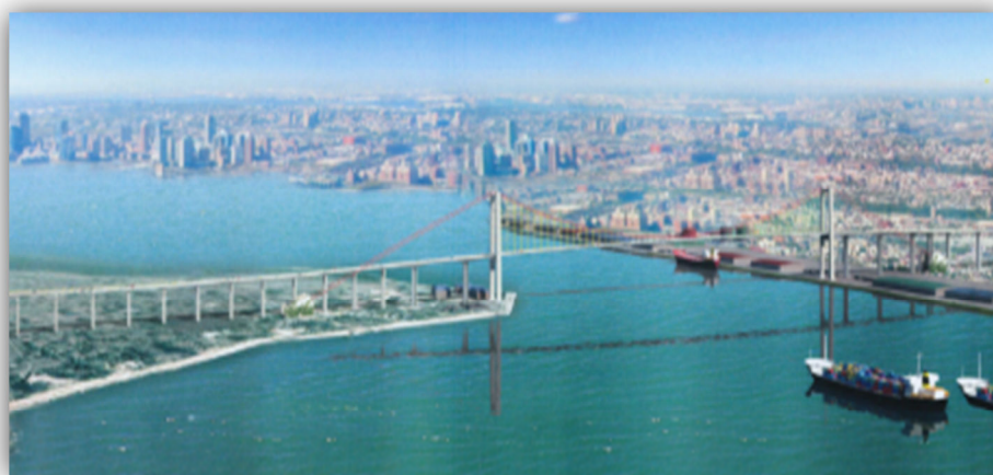
Fig. 1 - Vista geral da ponte Maputo-KaTembe
