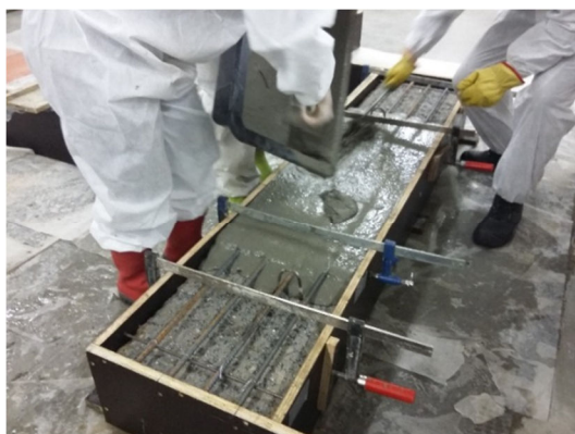
(a) Betonagem da camada de reforço
