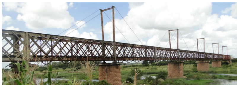
Fig. 1 - Linha de Goba - Antiga Ponte de Boane sobre o rio Umbelúzi.
