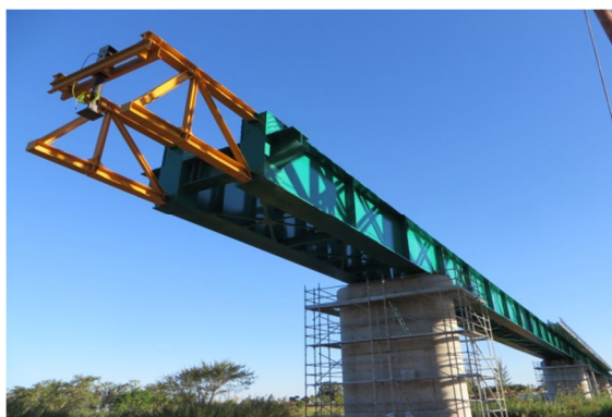
Fig. 3 - Lançamento incremental implementado em obra
