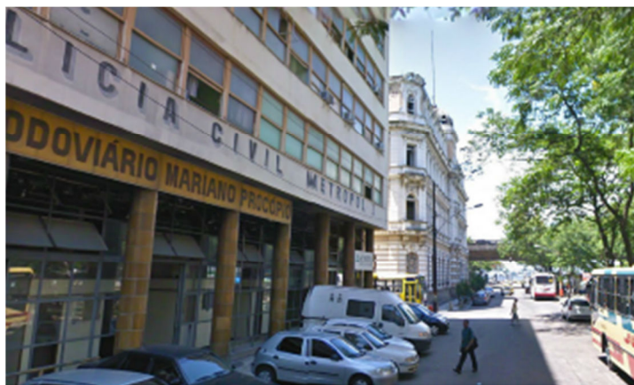
Fig. 4 - Terminal Rodoviário Mariano Procópio, antes das intervenções.
