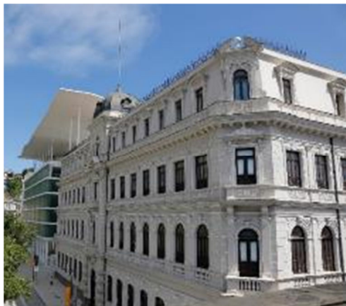
Fig. 7 - Fachada do Palacete após restauração. (Fonte: Concremat, 2013)
