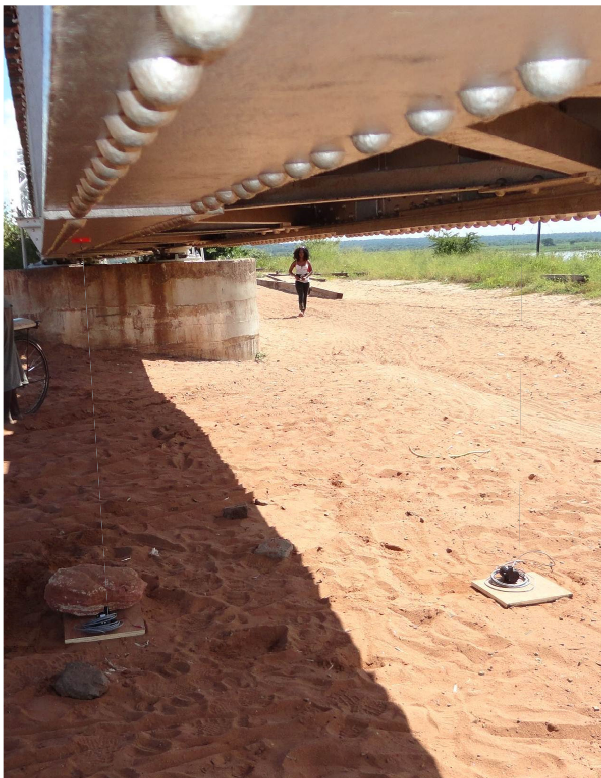
Fig. 18 - Montagem com defletómetros potenciométricos
