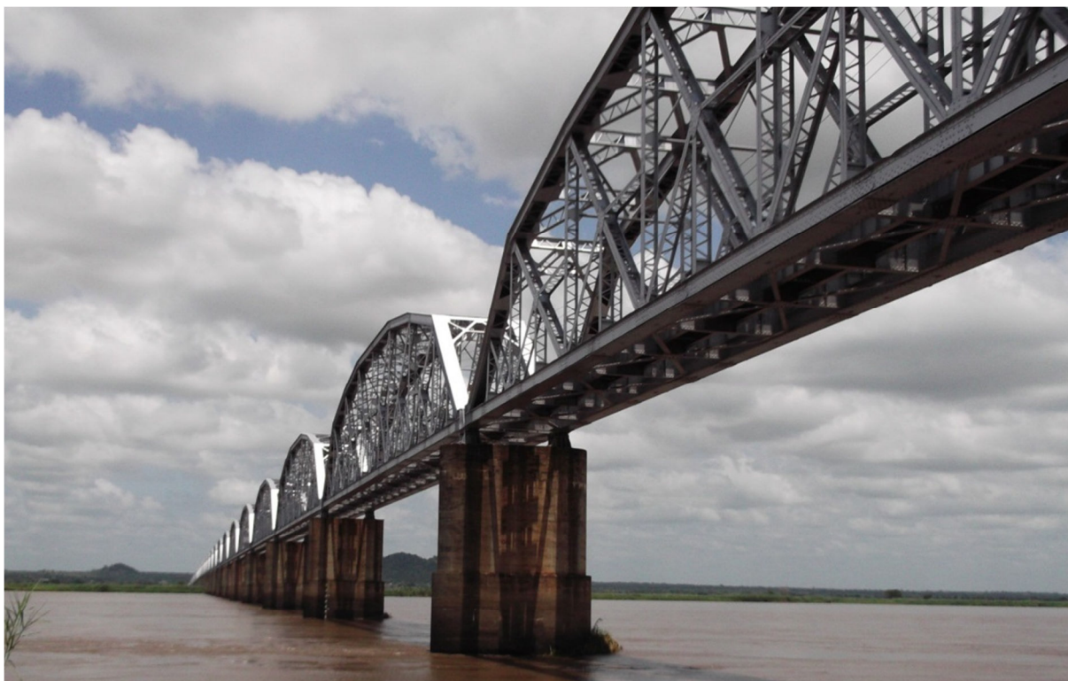
Fig. 7 - Ponte: viga treliçada com vão de 80 m
