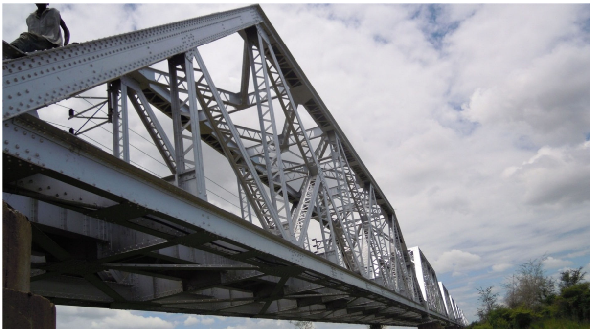
Fig. 6 Ponte: viga treliçada com vão de 50 m
