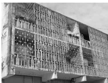
Edifício multifamiliar - elementos decorativos para sombreamento da parede exterior
