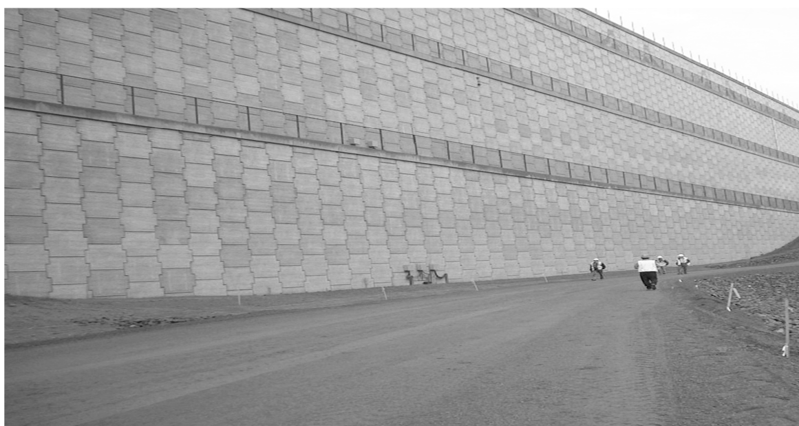
Fig. 4 - Sistema de contenção, terra armada, Maparagem 2011
