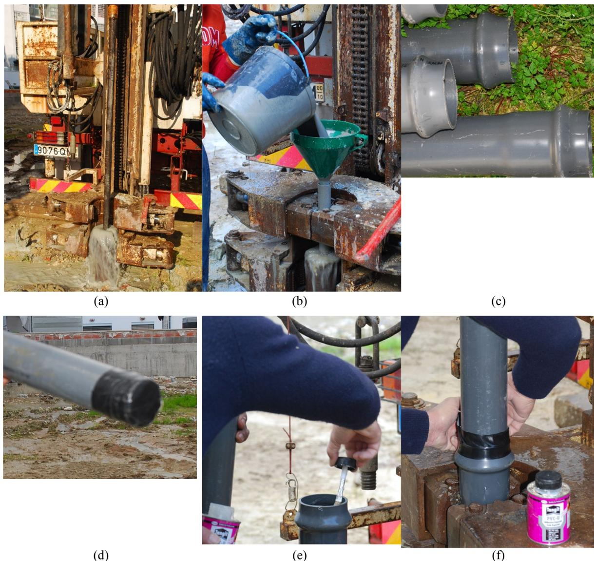
Fig. 5 - Montagem dos tubos de PVC para ensaios sísmicos no campo experimental: (a) aspeto geral da furação; (b) colocação da calda de cimento; (c) tubos com ligações UNI; (d) base do tubo obturada; (e) colocação de cola nas uniões entre trechos; (f) proteção das uniões com fita adesiva de alta resistência.
