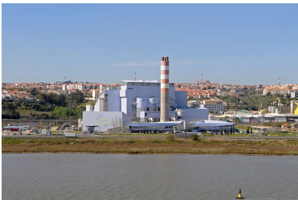
Fig. 1 - Central de tratamento de Resíduos Sólidos Urbanos da Valorsul.
