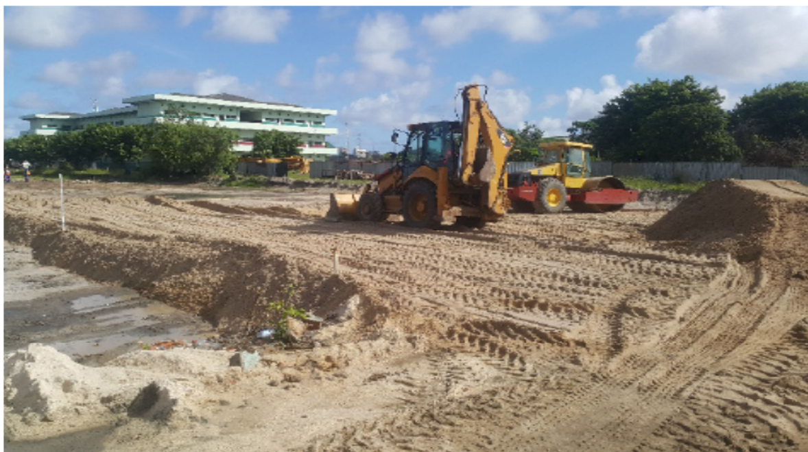
Fig. 24 - Aterro com uma camada de areia de 500mm de espessura e compactação dos solos
