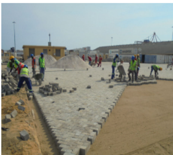
Fig. 11 e Fig. 12 - Colocação do revestimento em blocos de pavê
