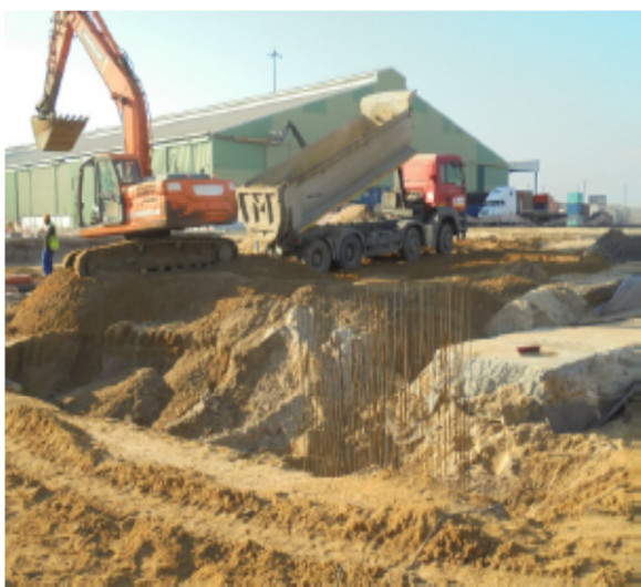
Fig. 2 e Fig. 3 - Aterro com uma camada de areia de 900mm de espessura
