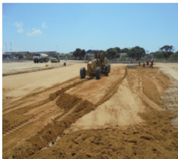
Fig. 2 e Fig. 3 - Aterro com uma camada de areia de 900mm de espessura
