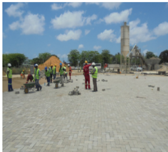
Fig. 11 e Fig. 12 - Colocação do revestimento em blocos de pavê
