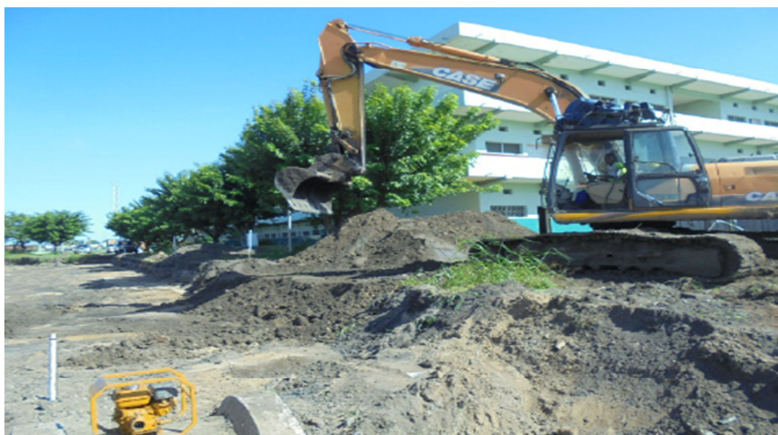
Fig. 22 - Escavação dos solos
