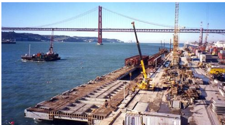
Fig. 3 - Vista Geral da Obra
