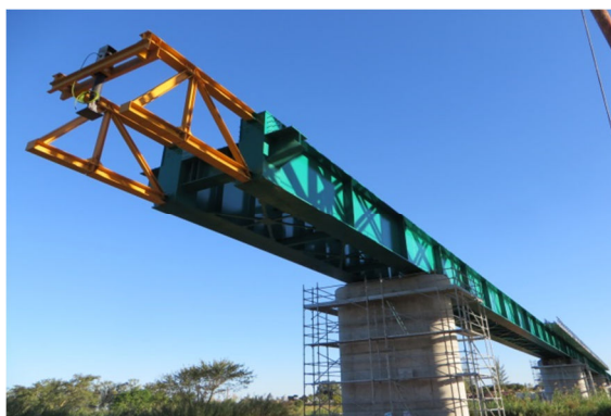
Fig. 3 - Lançamento incremental implementado em obra
