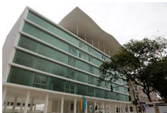
Fig. 14 - Fachada da Escola do Olhar, em vidro Channel Glass. (Fonte: Concremat, 2013)
