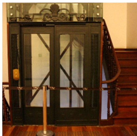
Fig. 8 - Elevador e escada originais do Palacete, restaurados. (Fonte: Silva, 2017)
