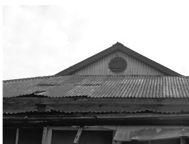
Edifício unifamiliar - abertura no desvão da cobertura para renovação do ar
