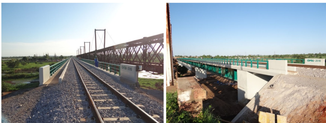
Fig. 4 - Aspecto final da obra
