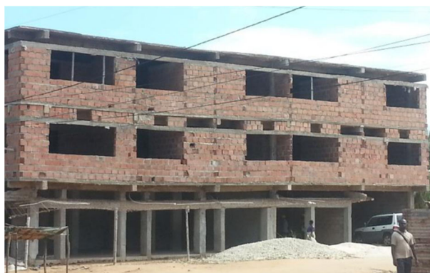
Vista geral do edifício
