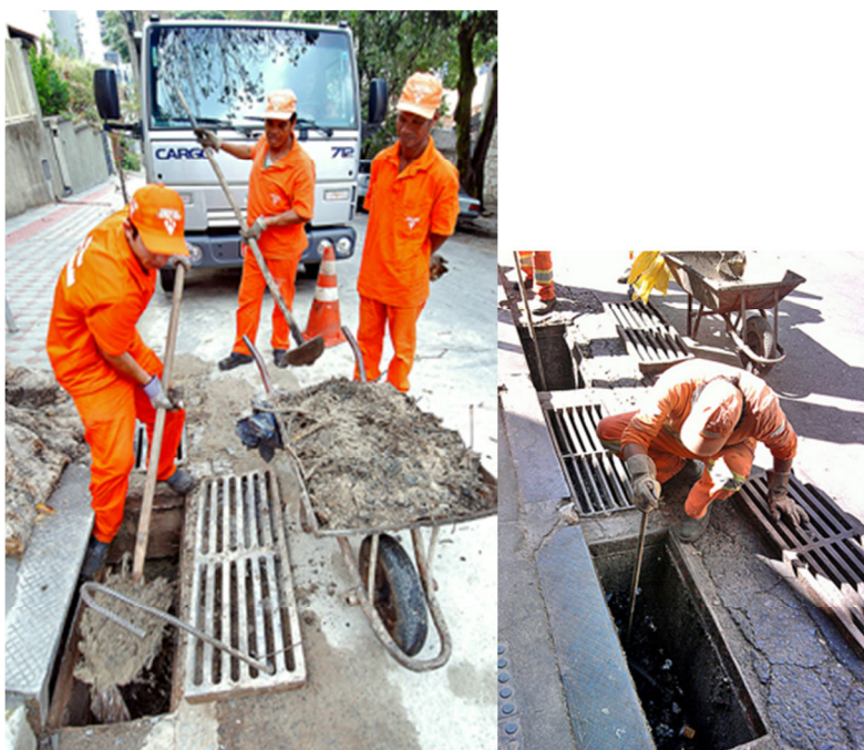
Fig. 1 - Retirada de entulho e lixo em bocas de lobo de Belo Horizonte Fonte: http://portalpbh.pbh.gov.br/pbh
