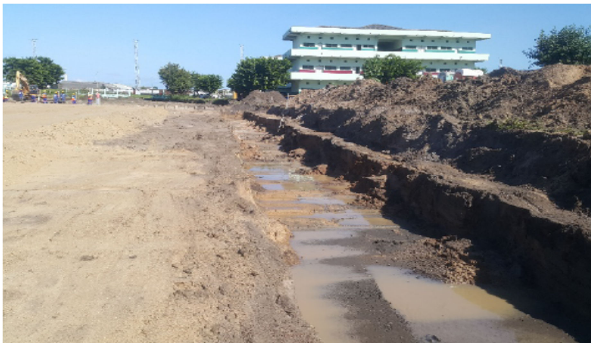
Fig. 23 - Escavação para construção de elementos de drenagem superficial
