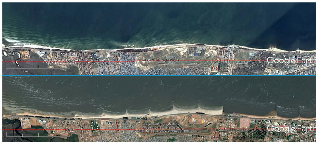
Fig. 1 - Área de estudo antes e após a recente intervenção de protecção costeira (Imagens adaptadas do Google Earth)
