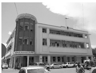
Edifício de serviços - varandas recuadas e sombreamento da envolvente
