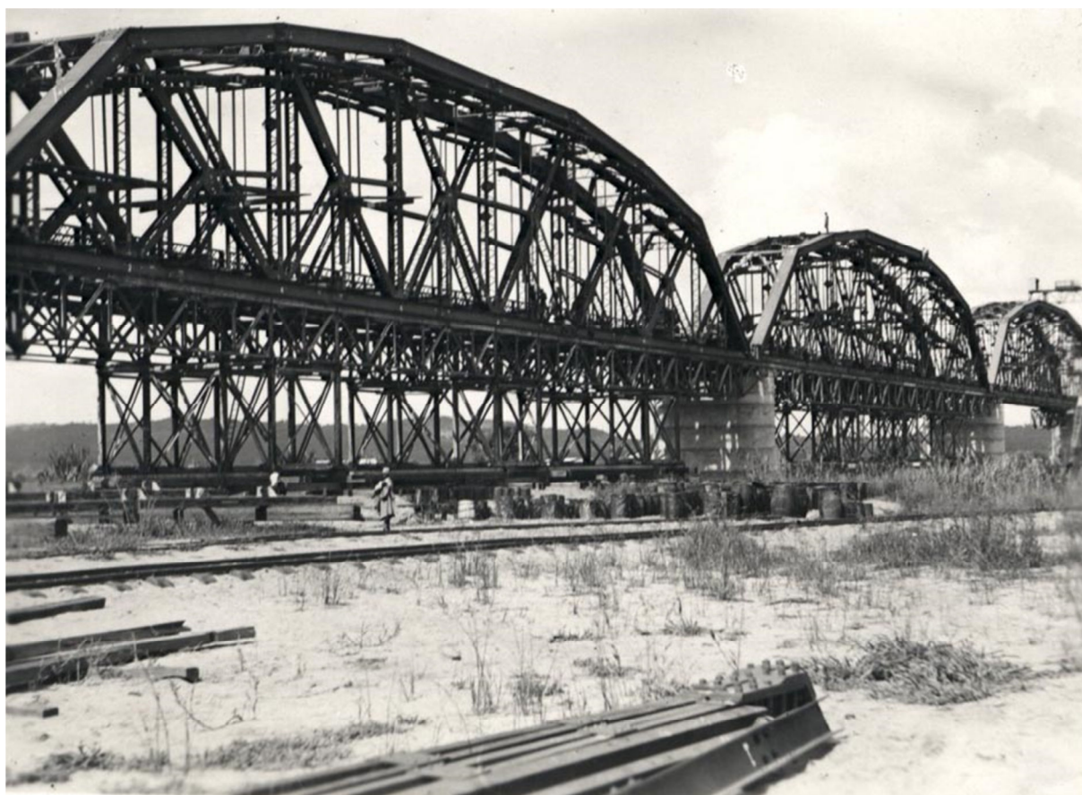
Fig. 2 - Construção da ponte de Dona Ana
