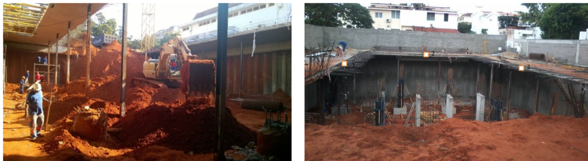
Fig. 1 - Imagens da Fase de Escavação do Edifício A.
