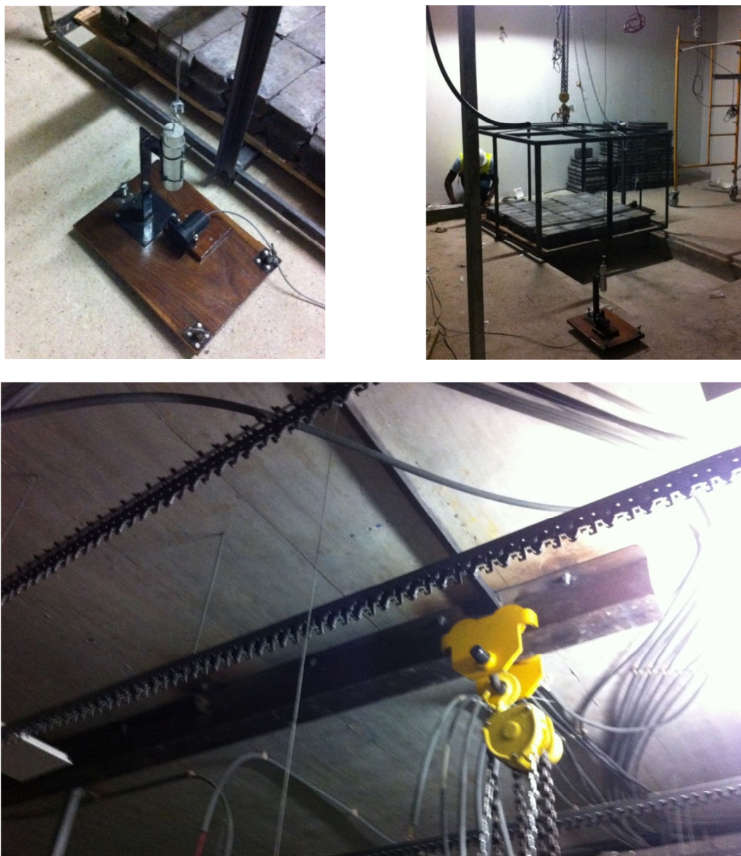
Fig. 9 - Sistema de medição das deformações na viga e na laje durante a condução do ensaio de carga
