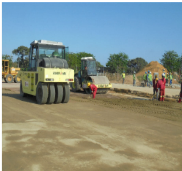
Fig. 9 e Fig. 10 - Execução de uma camada de 540mm em solo-cimento
