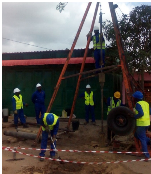
a) Sondagem à Percussão com SPT.
