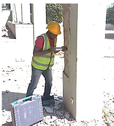
(a) Caracterização in-situ do betão
