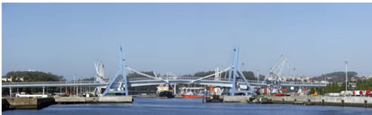
Fig. 1 - Vista Geral da Nova Ponte Móvel de Leixões
