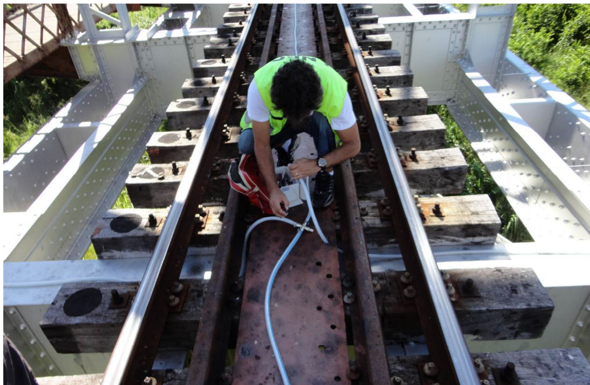
Fig. 19 - Fase de montagem do sistema de nivelamento hidrostático
