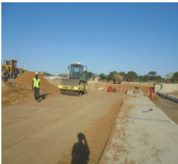
Fig. 7 e Fig. 8 - Colocação de uma camada de 150mm em pedra britada
