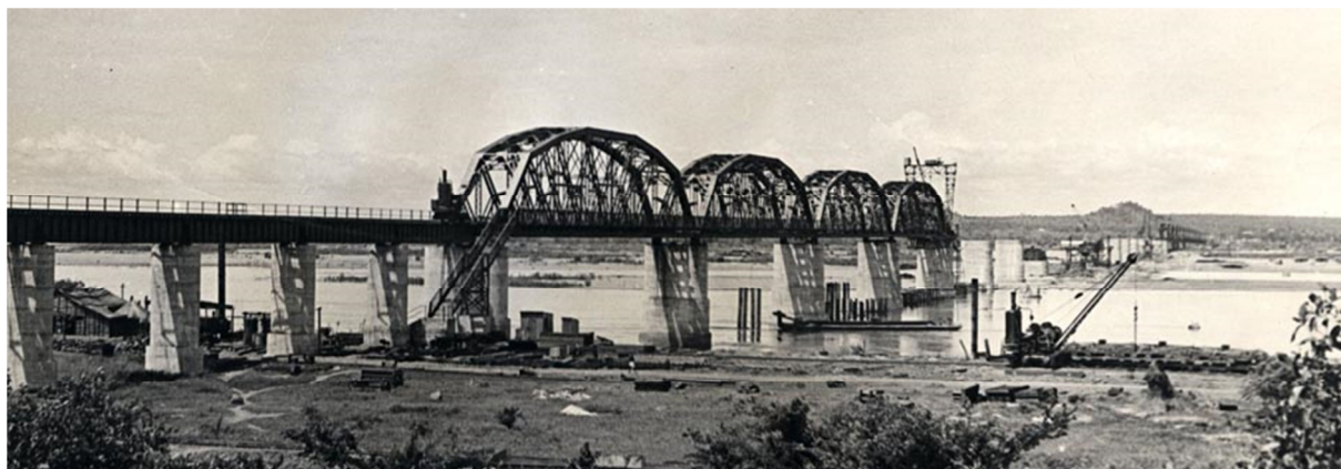
Fig. 1 - Construção da ponte de Dona Ana
