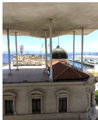
Fig. 10 - Cobertura do Palacete, vista da Escola do Olhar. (Fonte: Silva, 2017)
