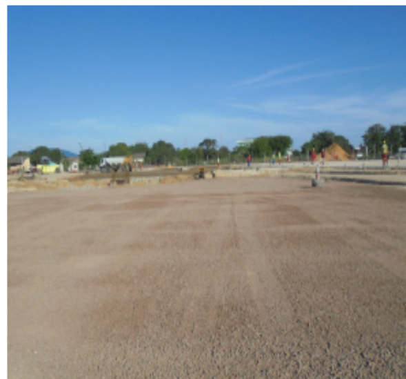
Fig. 7 e Fig. 8 - Colocação de uma camada de 150mm em pedra britada
