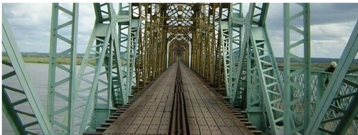
Fig. 3 - Tabuleiro rodoviário da Ponte Dona Ana
