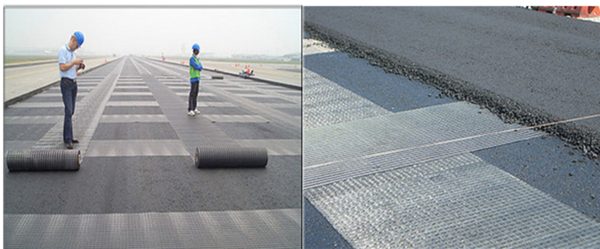
Fig. 3 - Geossintéticos utilizados como reforço [IGS@ 2016]
