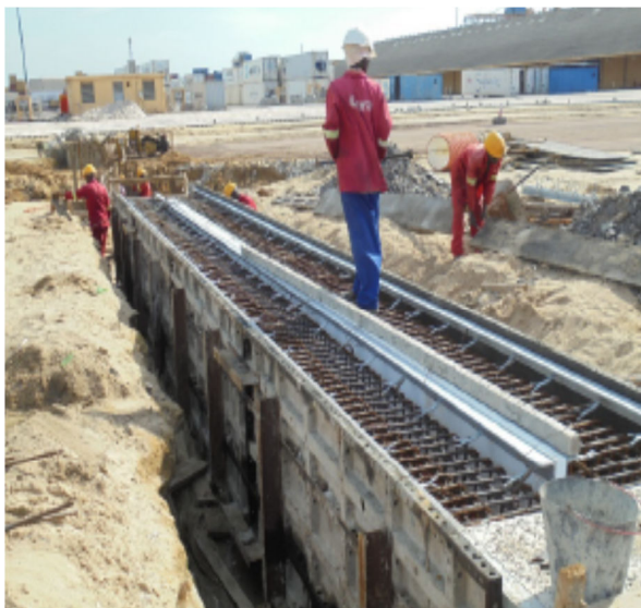
Fig. 4 e Fig. 5 - Construção de elementos de drenagem superficial e subterrânea
