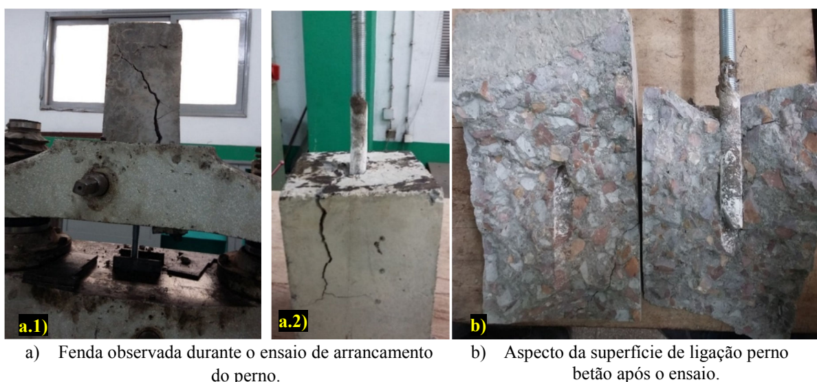
Fig. 8 - Ensaio de arrancamento do perno: modo de rotura observado por fendilhação do betão.
