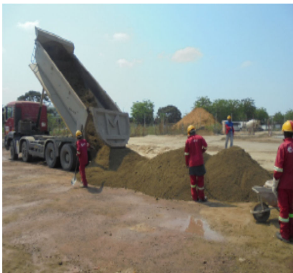
Fig. 9 e Fig. 10 - Execução de uma camada de 540mm em solo-cimento
