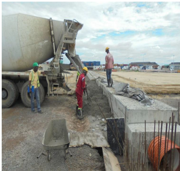
Fig. 4 e Fig. 5 - Construção de elementos de drenagem superficial e subterrânea
