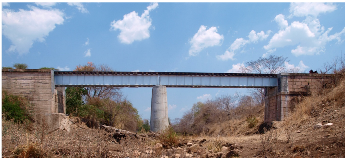
Fig. 8 - Alçado este da Ponte 29: km 416+460
