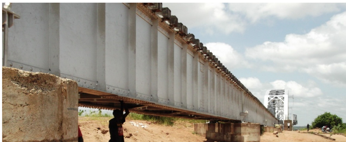
Fig. 5 - Vista geral do Viaduto Norte (Mutarara)
