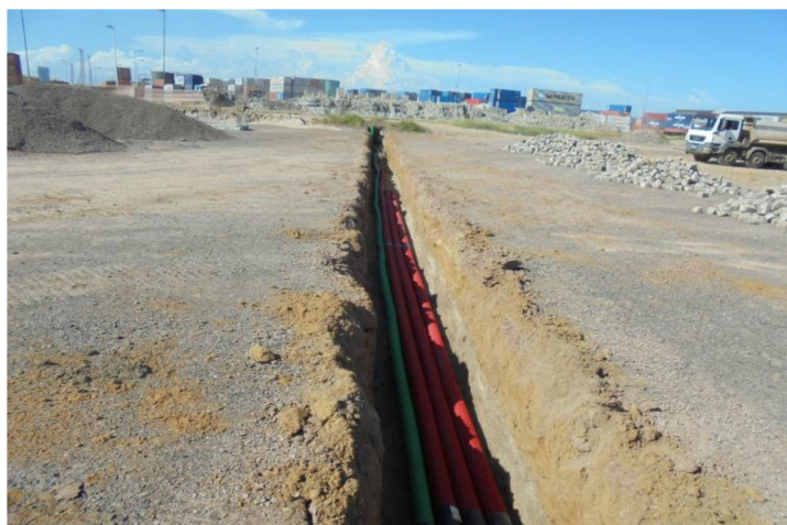
Fig. 6 - Instalação de condutas que irão permitir a distribuição da rede de cabos eléctricos e de dados
