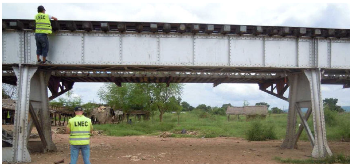
Fig. 9 - Viaduto sul: tramo de 9,70 m
