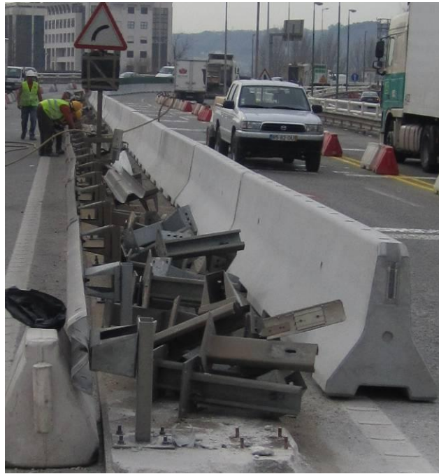
Figura 8 – Instalação do sistema “Delta Bloc” na Ponte do Açude em Coimbra. Substituição de barreira metálica existente dada a sua comprovada ineficácia.
