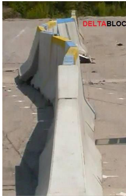
Figura 6 – Deformação do sistema após embate.
