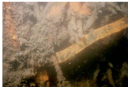
Figura 2.4- Imagem de um pedaço de betão danificado
