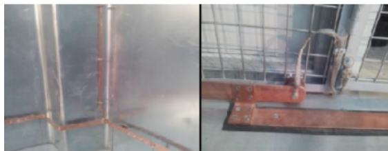
Figura 4.3: Interligações ao barramento principal;
