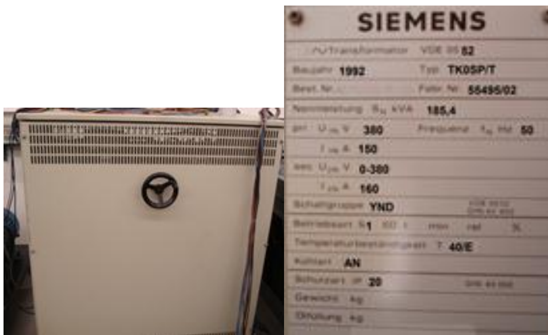
Figura 8.7 - Autotransformador trifásico da Siemens
