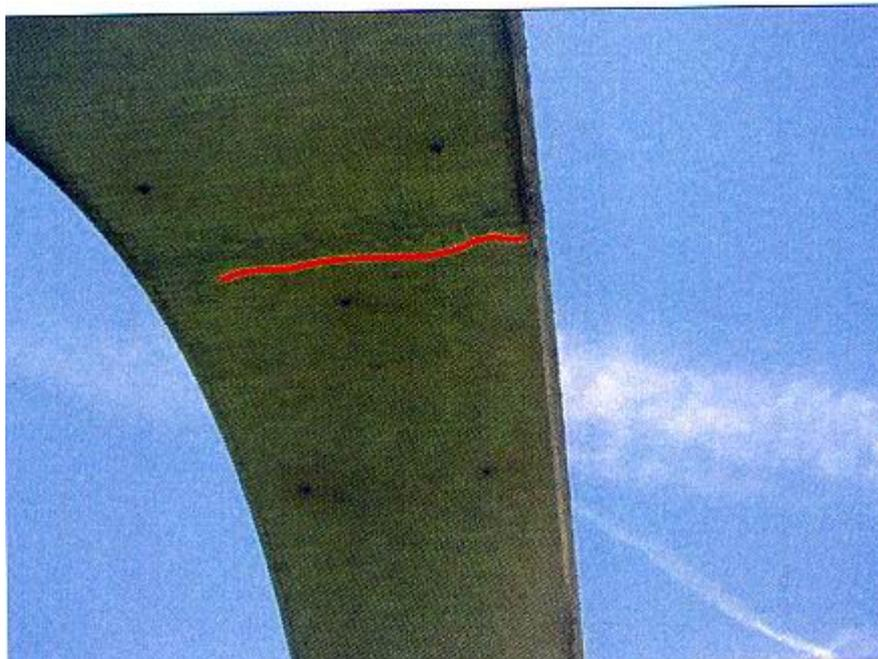
Figura 13 - Vista inferior do arco – existência de fissuras que permitem a passagem de água denunciada pela existência de estalactites
