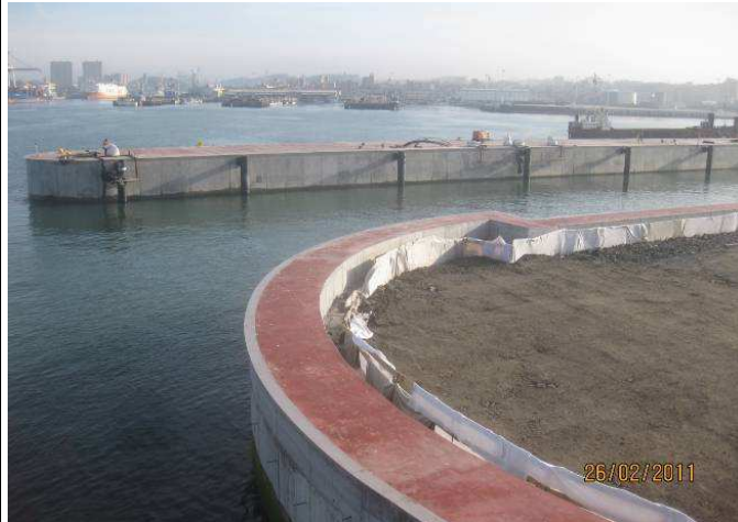
Fig. 3.133 – Viga de coroamento completa.
