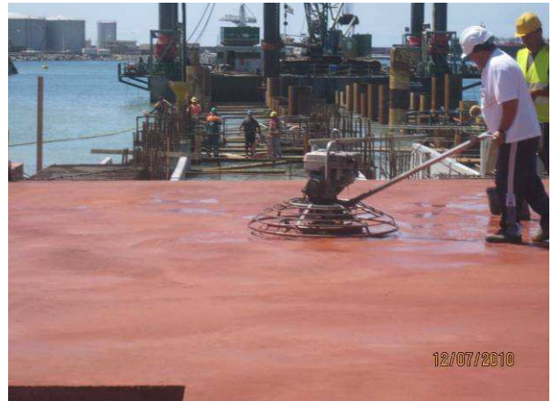
Fig. 3.88 – Acabamento superficial final.
