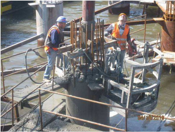
Fig. 3.74 – Fim da betonagem de uma estaca.
