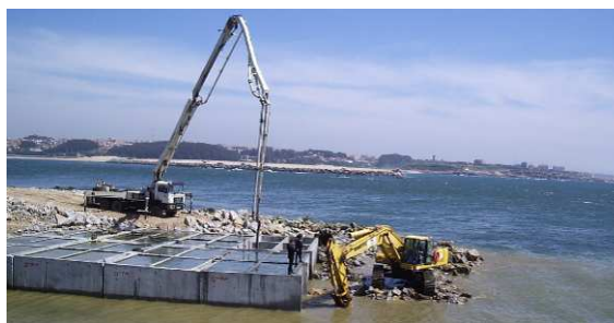
Fig. 2.81 – Aterro e enrocamento como obra auxiliar para a colocação de aduelas (Molhes do Douro) [17].
