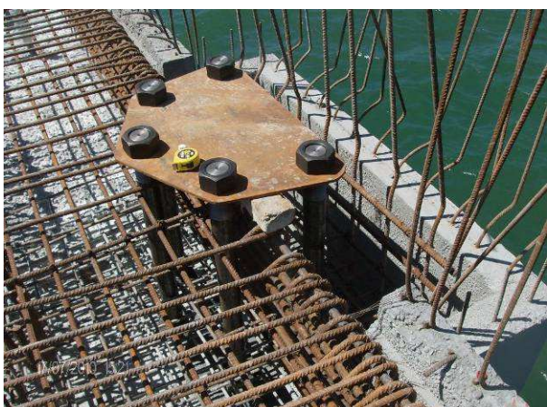
Fig. 3.91 - Chumbadouros e cércea de um cabeço.
