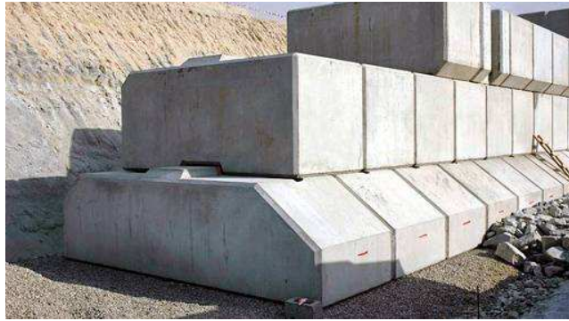
Fig. 2.60 – Muro de gravidade num Porto de Recreio no Dubai [61].
