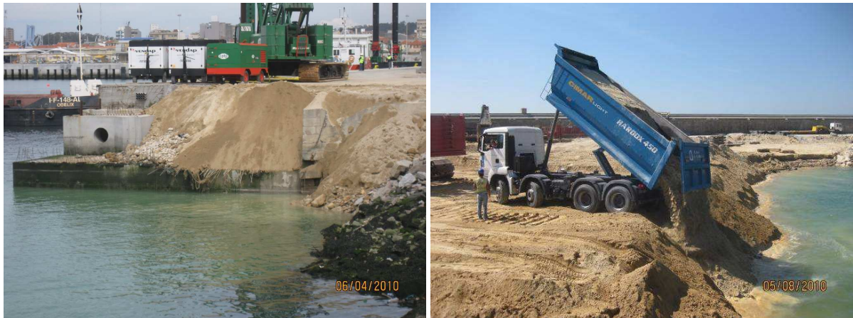
Fig. 3.47 - Fotografias do início e progressão do aterro da plataforma do edifício.
