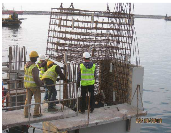
Fig. 3.82 – Colocação de armadura num escudete.
