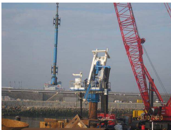
Fig. 3.105 – Coluna de furação com “bit” acoplado.
