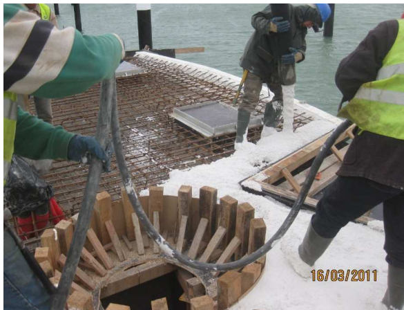
Fig. 3.112 – Betonagem da Ilha Ecológica.
