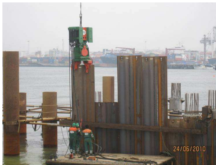
Fig. 3.76 - Cravação de estacas-prancha com “vibrofonceur”.
