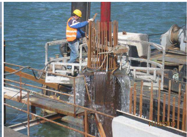
Fig. 3.73 – Decorrer da betonagem de uma estaca.
