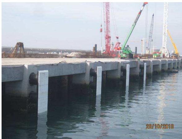
Fig. 3.90 - Aplicação de defensas.
