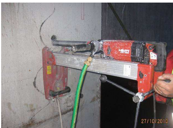
Fig. 3.89 – Execução de carotagem.
