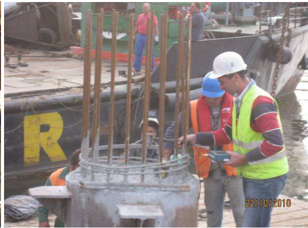
Fig. 3.75 – Ensaio sónico a uma estaca betonada.
