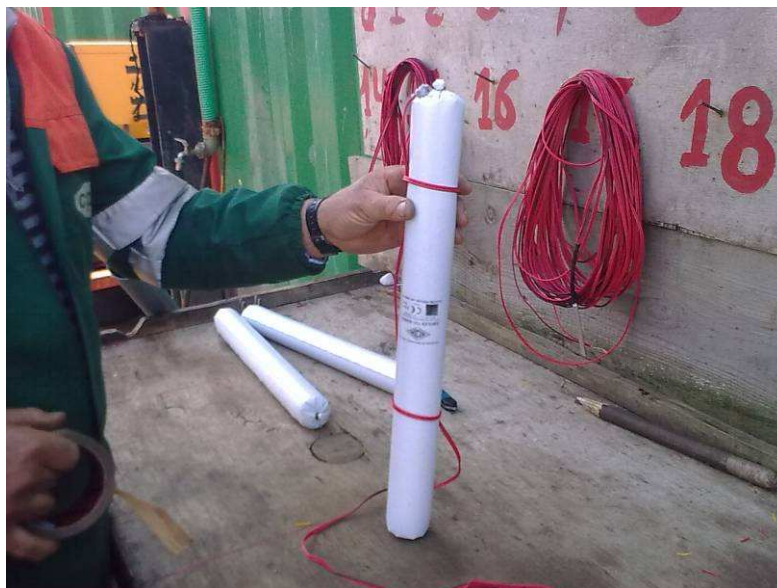
Fig. 3.38 - Preparação dos explosivos no pontão “Montemor” (25-02-2011).
