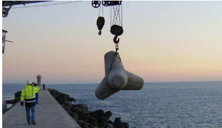
Fig. 2.50 – Colocação de tetrápodes de 400kN no Molhe Norte do Porto de Leixões [58].
