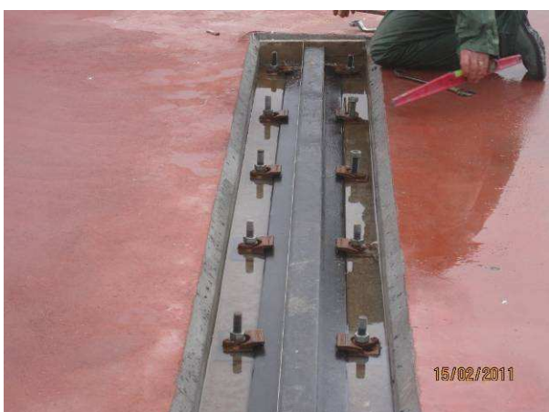
Fig. 3.99 – Colocação do carril sobre as mesas.
