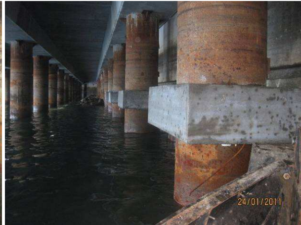
Fig. 3.78 - Fotografia do maciço betonado.
