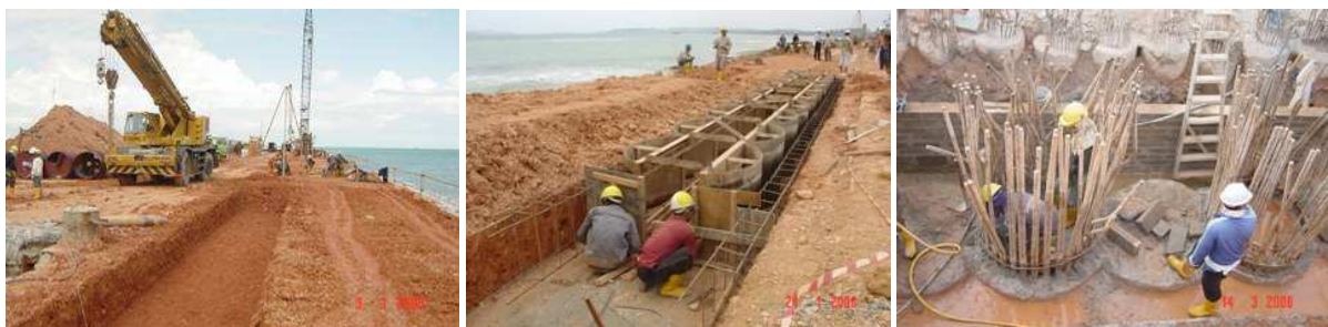
Fig. 2.79 – Execução de uma cortina de estacas de betão armado [65].
