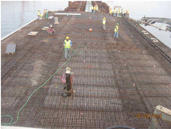
Fig. 3.87 – Início de uma betonagem de laje.
