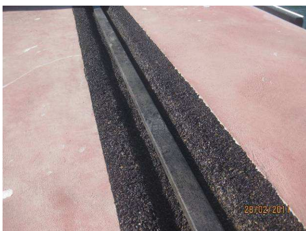
Fig. 3.100 – Acabamento final com betuminoso.
