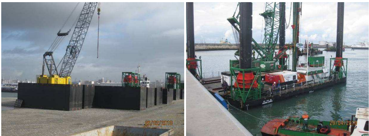
Fig. 2.38 – Início e fim da montagem do “Perna Longa” – Plataforma “Jack-up” da obra exemplo.
