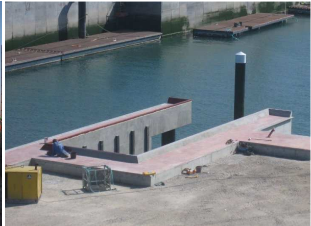
Fig. 3.129 – Estrutura do “travelift” (22-03-2011).
