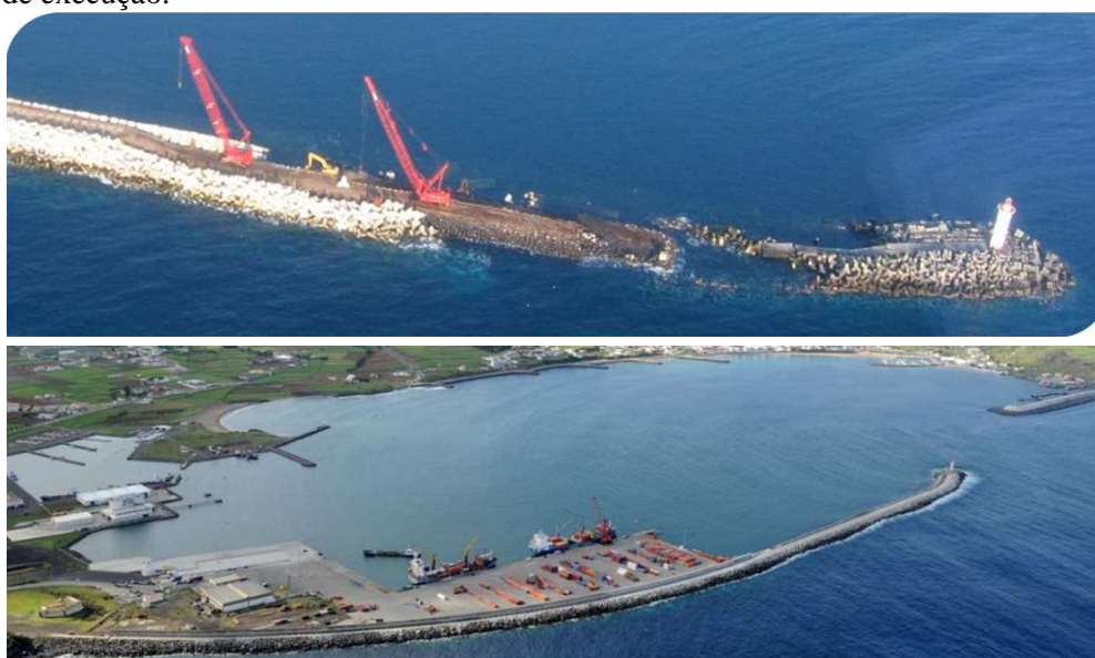
Fig. 2.49 – Reconstrução do Molhe Sul do Porto da Praia da Vitória, Açores [58].
