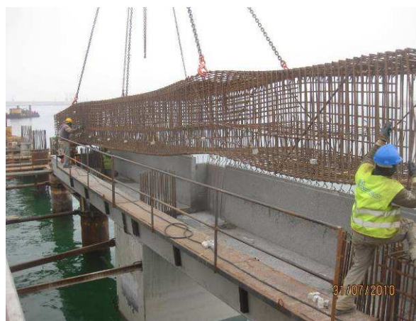
Fig. 3.84 – Colocação da armadura numa viga.
