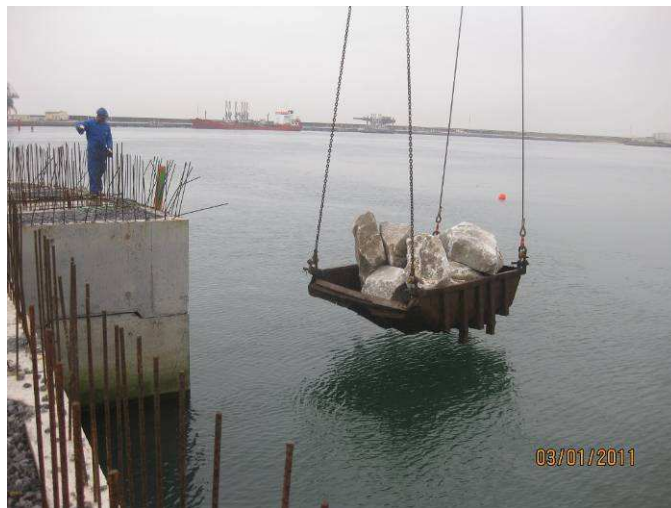
Fig. 3.56 - Protecção do prisma de fundação das aduelas com enrocamento numa cassamba.
