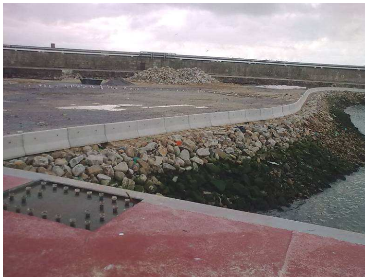
Fig. 3.54 - Retenção marginal do aterro da gare de passageiros (22-02-2011).
