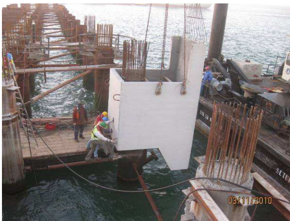
Fig. 3.81 – Colocação de um escudete pré-fabricado.
