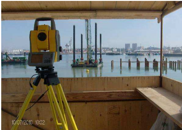
Fig. 3.64 - Apoio topográfico ao “Perna Longa”.
