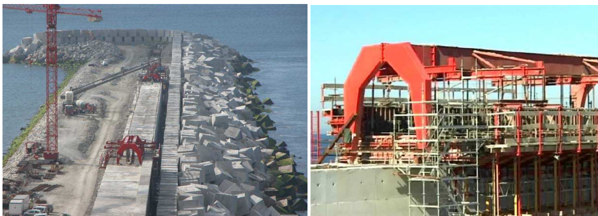
Fig. 2.54 – Execução do muro de coroamento com deflector do quebramar do Porto do Ferrol [74].
