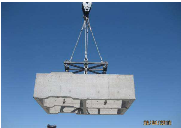
Fig. 4.12 - Movimentação de uma aduela em estaleiro.
