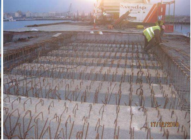
Fig. 3.86 – Colocação de uma série de pré-lajes.
