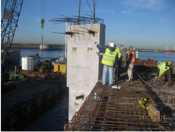
Fig. 3.85 – Colocação de um painel do intradorso.
