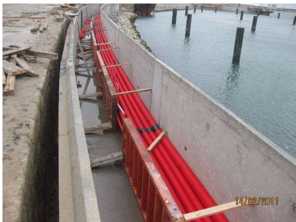
Fig. 3.60 – Execução da Galeria Técnica.
