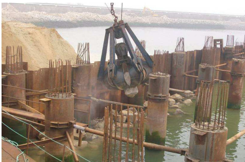
Fig. 3.50 – Fotografia da retenção marginal do cais acostável (26-06-2010).
