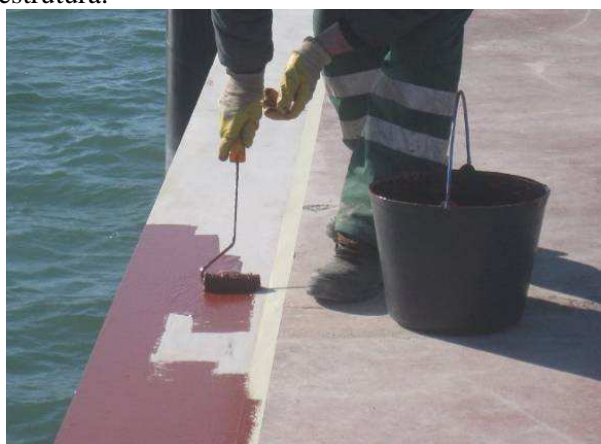
Fig. 4.10 – Acabamento de superfície (pintura).
