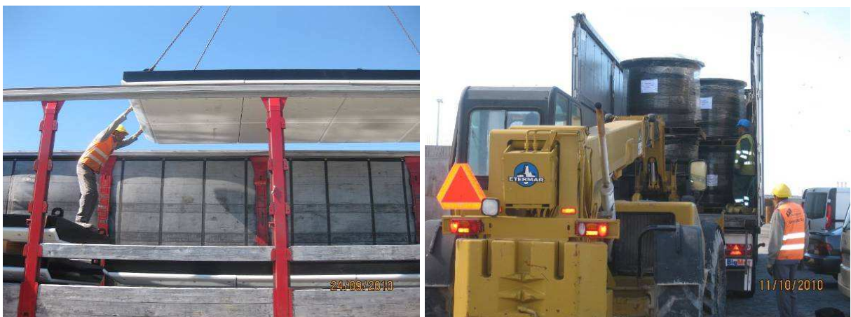
Fig. 4.16 – Recepção das defensas em obra.
