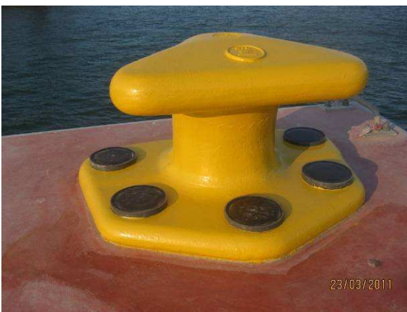
Fig. 3.92 - Cabeço de amarração colocado.
