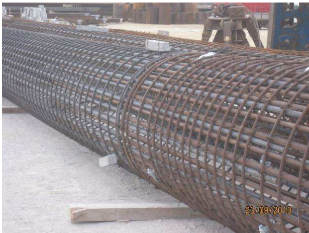
Fig. 3.68 - Empalme de armaduras das estacas.
