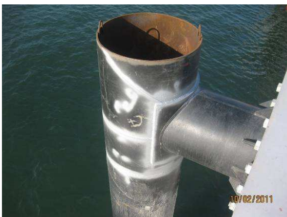
Fig. 4.11 – Tratamento anticorrosivo em estaca soldada.
