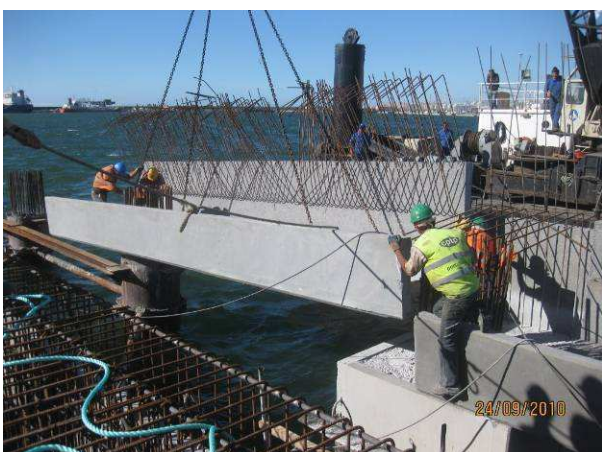
Fig. 3.83 – Colocação de um canalete pré-fabricado.
