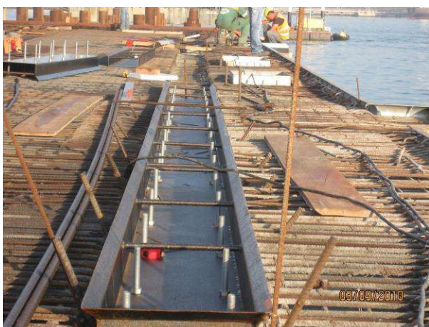
Fig. 3.97 – Negativo na laje e chumbadouros.
