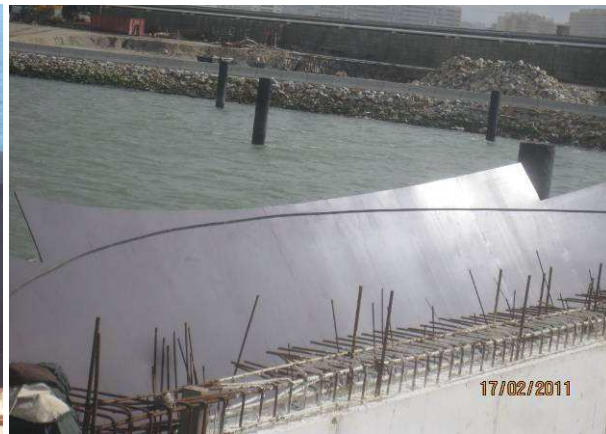
Fig. 4.3 – Cofragem da Ilha antes da betonagem.
