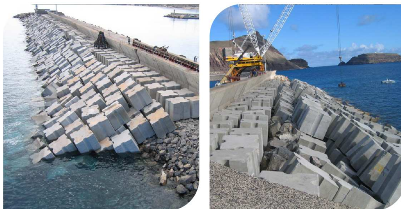
Fig. 2.51 – Reparação do manto resistente com pré-fabricados no Molhe Principal do Porto de Porto Santo [58].
