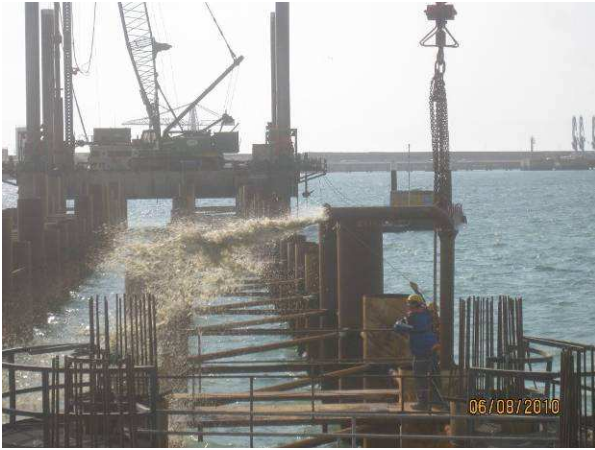
Fig. 3.70 – Saneamento de uma estaca com "air-lift".
