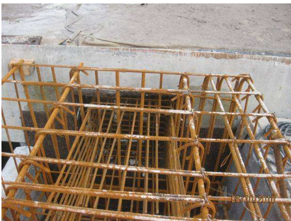
Fig. 3.95 – Armadura do “dente” da junta.
