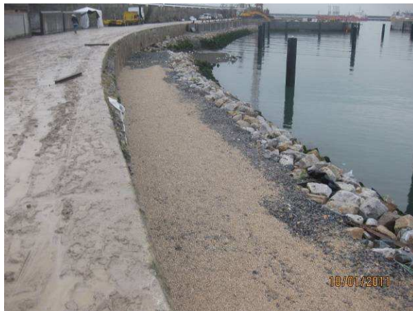
Fig. 3.59 - Trabalhos de reperfilamento do Molhe Sul.
