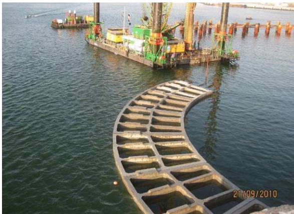
Fig. 3.122 - Fotografia da progressão do muro-cais.
