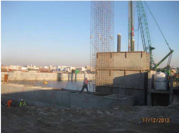
Fig. 3.128 – Colocação da armadura no pilar.
