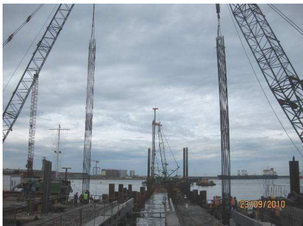
Fig. 5.3 – Colocação de armaduras de duas estacas em simultâneo com recurso a duas guias.
