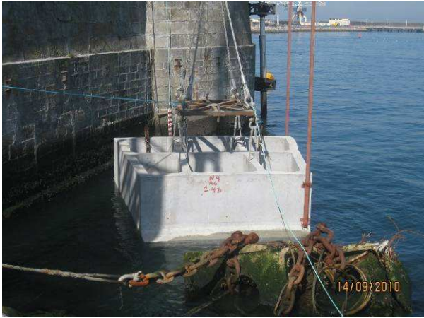
Fig. 3.120 - Colocação da primeira aduela de fundo.
