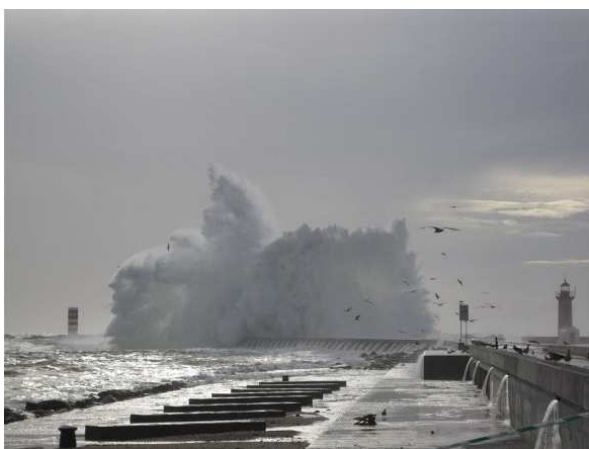
Fig. 5.5 – Galgamento do Molhe do Douro, um quebramar de parede vertical, perto do Porto de Leixões [17].
