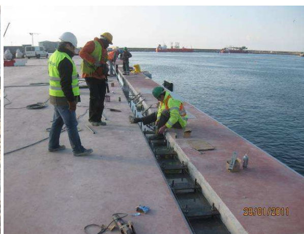
Fig. 3.98 – Negativo descofrado e mesas transversais.
