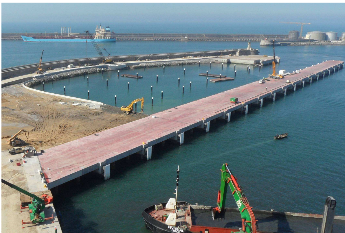
Fig. 3.140 – Fotografia da obra concluída (18-03-2011).
