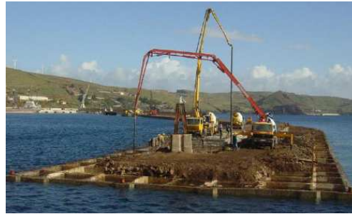
Fig. 2.56 – Quebramar exterior de parede vertical do Porto do Caniçal – Madeira [58].
