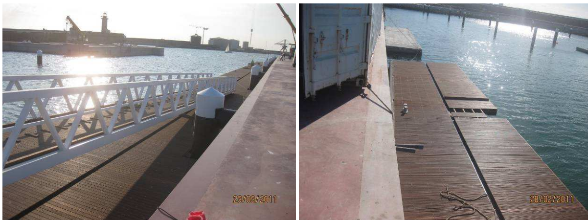
Fig. 3.102 – Rampa de acesso ao cais Flúvio-Marítimo. Fig. 3.103 – Quebramar flutuante com convés revestido.
