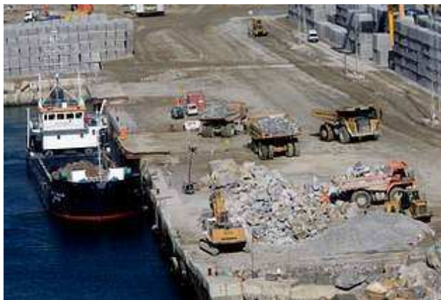
Fig. 2.82 – Estruturas auxiliares para abastecimento de batelões com enrocamento [71].
