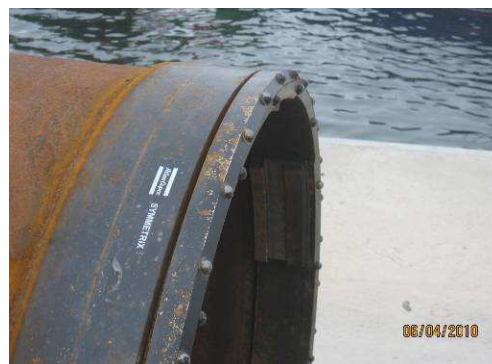
Fig. 3.66 – Extremidade de uma estaca com sistema “Symmetrix” acoplado.
