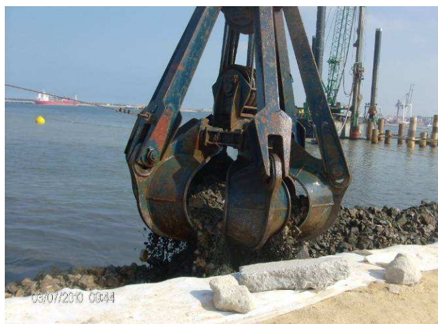
Fig. 3.52 - Retenção marginal do aterro da Gare de Passageiros com geotêxtil e enrocamento.
