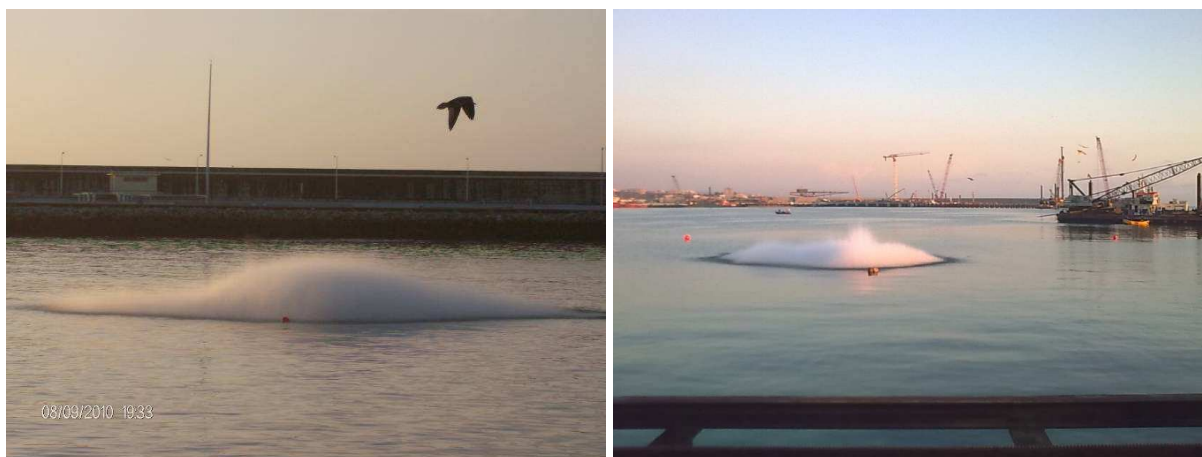
Fig. 3.46 - Instantes da detonação de pegas de fogo.
