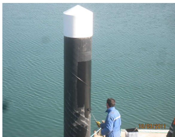
Fig. 3.109 – Estacas metálicas terminadas.
