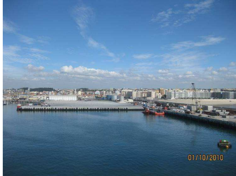
Fig. 3.8 – Fotografia do cais multiusos.
