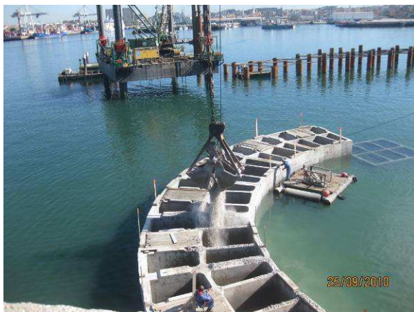
Fig. 3.125 - Preenchimento das células com brita.
